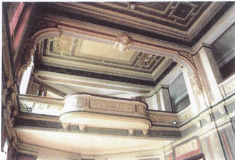
POHLED NA BALKÓN A ZDOBENÝ STROP
