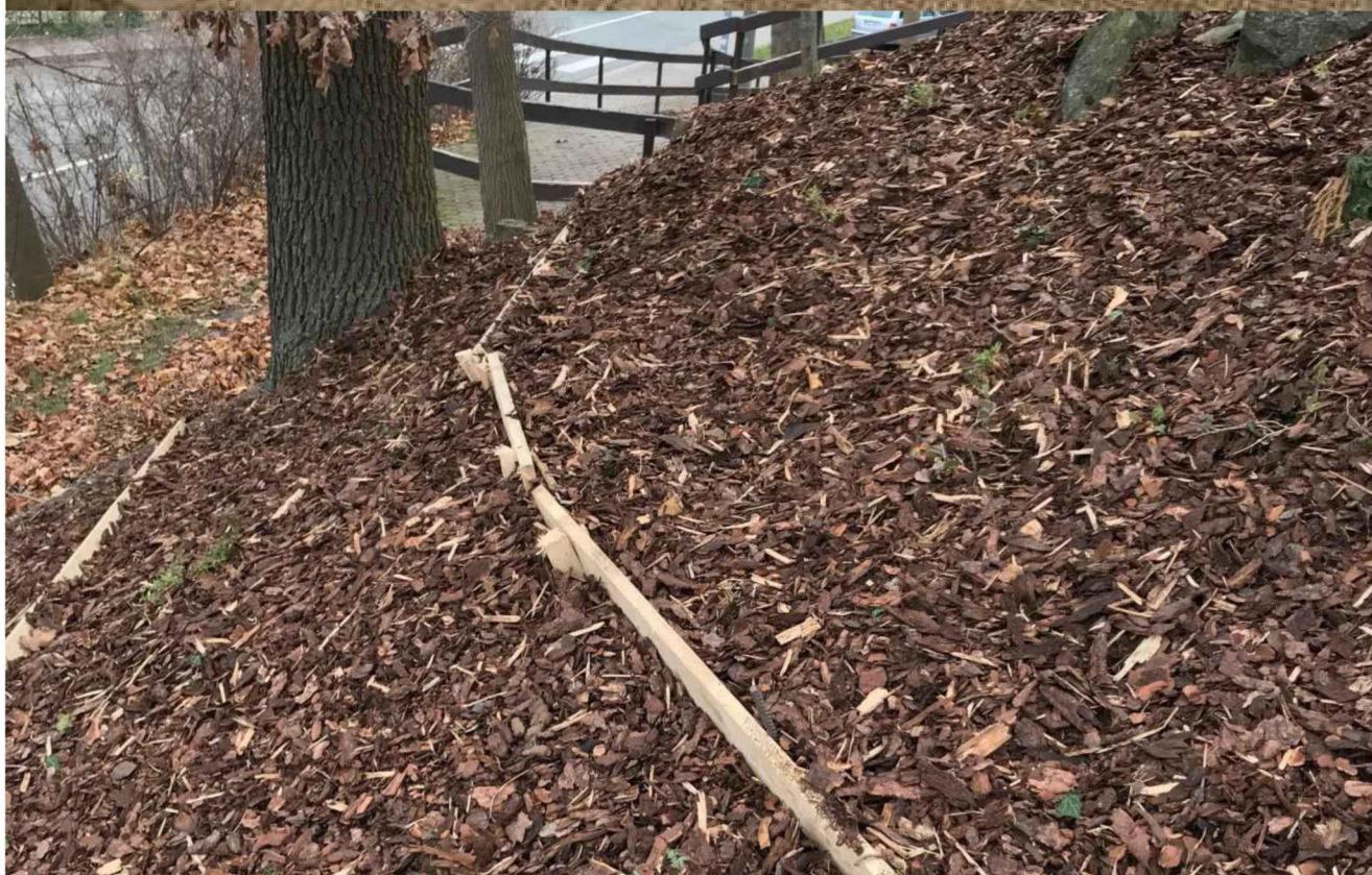
ukázka zpevnění svahu jutovou sítí a následně eliminace sesuvu mulče pomocí instalace dřevěných prken
