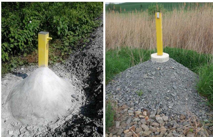
Obrázek 17 Řešení zhotovitele pro zvýšení stability zajišťovací značky
