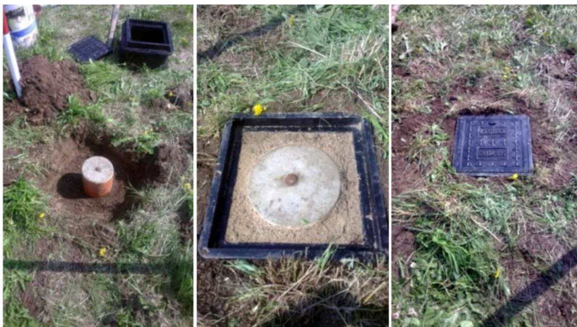
Obrázek 41 Příklad řešení plastové šachty hranaté
