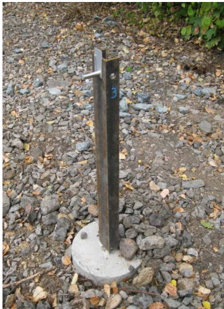
Obrázek 20 Otevřený profil konstrukce sloupku ŽPSV
