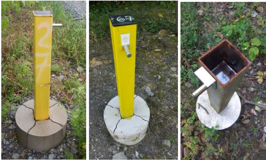
Obrázek 19 Popraskané betonové základy zajišťovacích značek ŽPSV
