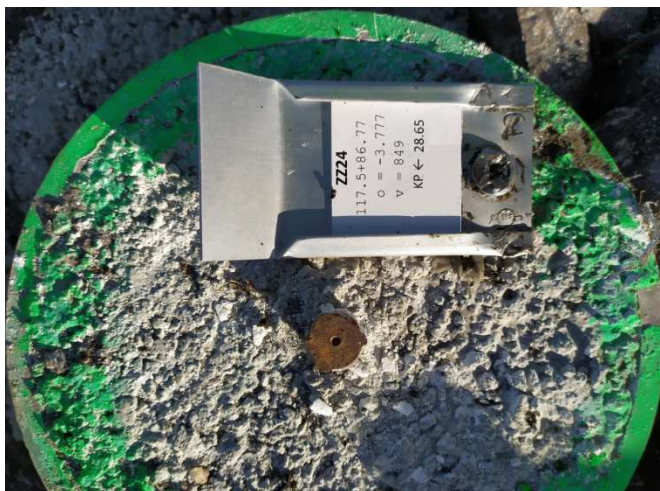
Obrázek 33 Roxor v betonovém bloku (základní odlehčená stabilizace)
