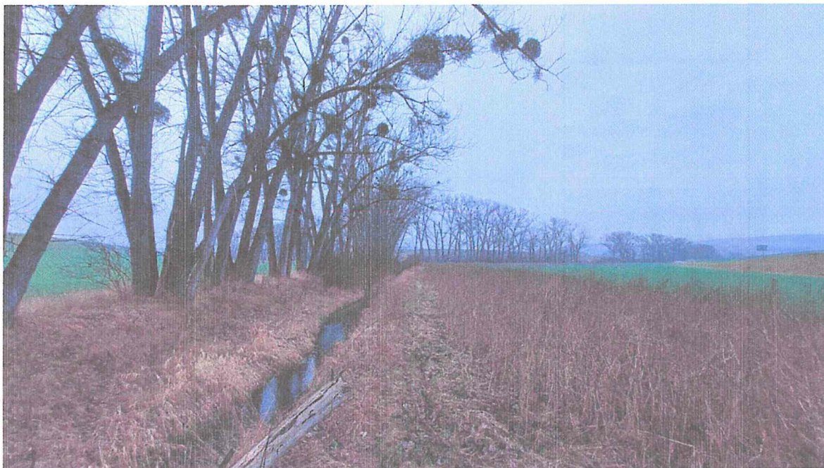
Obr. č. 9: Pohled z levého břehu Lovčického potoka, vzadu souvislý břehový porost topolů Soudného potoka
