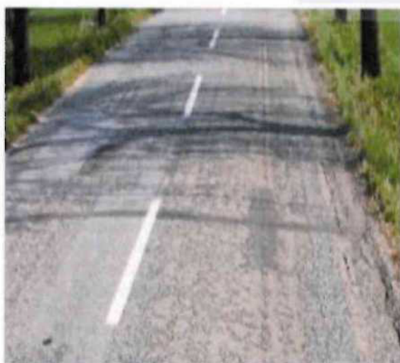
Barvné odlišné místa se ztrátou kameniva z nátěru.
