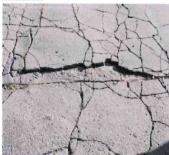
Výtluk vzniklý z mezikovových trnů.
