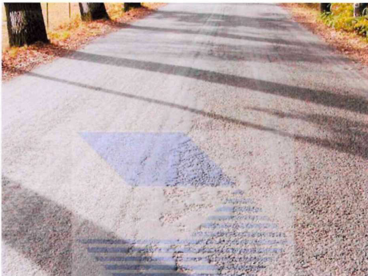
Ztráta kameniva z nátěru s vystouplým pojivem na povrchu vozovky.
