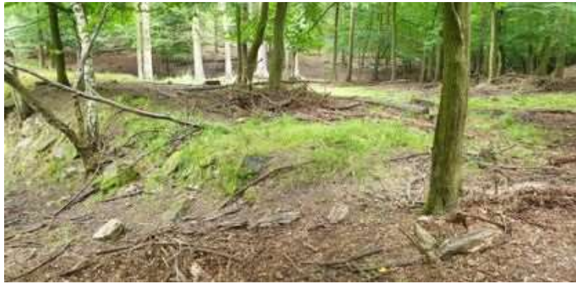
6. Pohled na pravé zavázání hráze
