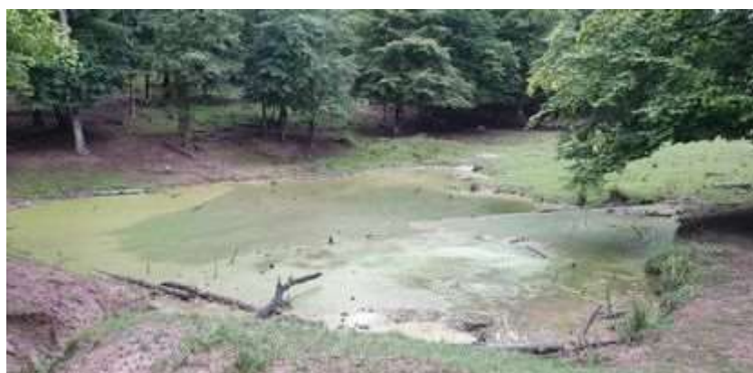
5. Pohled z levého závazání hráze do zátopy
