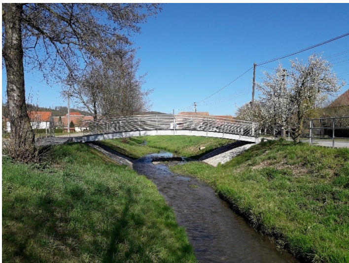
Silniční most v ř.km 6,630
