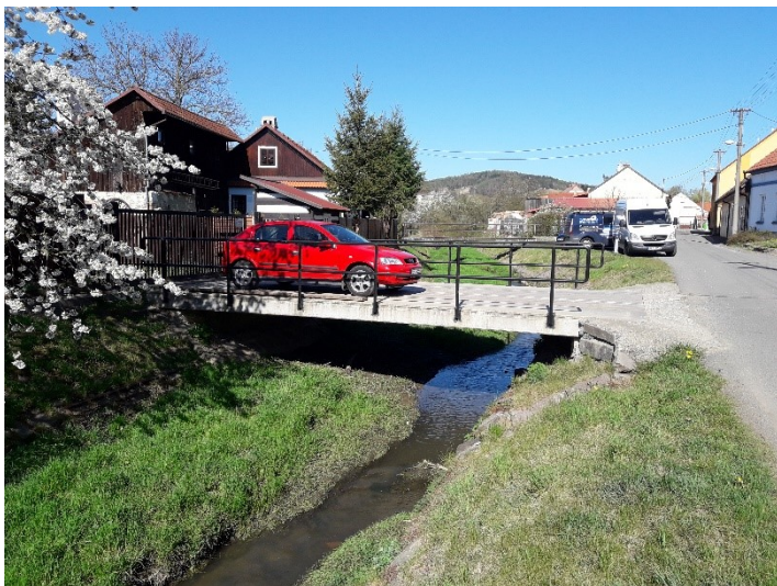
Ř.km cca 6,700 – viditelné opevnění na levém břehu
