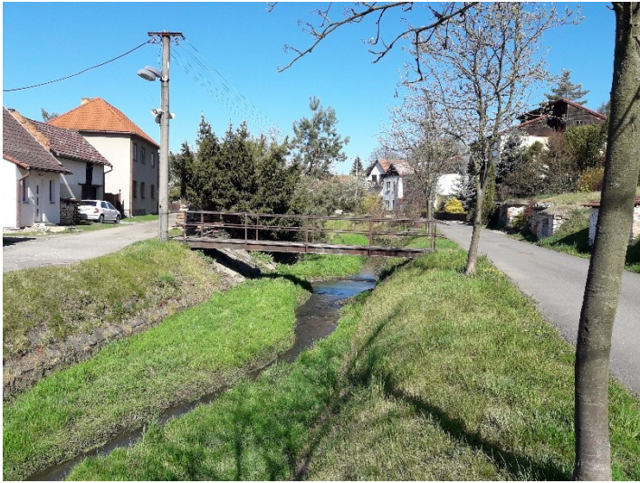
Silniční most v ř.km 7,090
