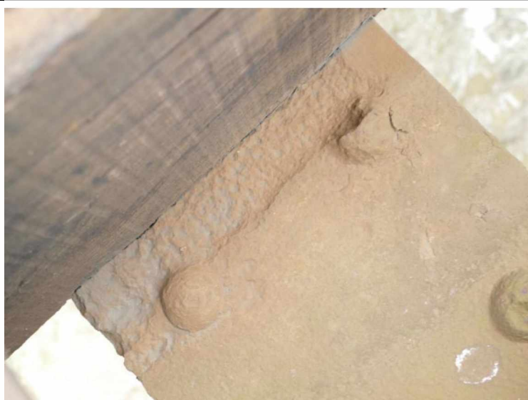
Konstrukce K 01: Korozní oslabení horní pásnice hlavního nosníku
