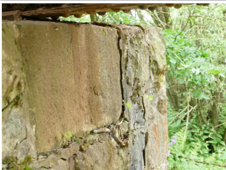
Křídlo O 01 vpravo: Počínající vysouvání zdiva dříku v horní části
