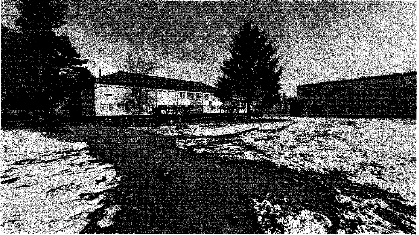
Stávající 1. část chodníku vybudovaná v roce 2022.
