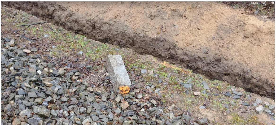
Obrázek 46 Vedení výkopu přes původní polohu geodetického bodu - bod musí být znovu osazen a zaměřen polohově i výškově
