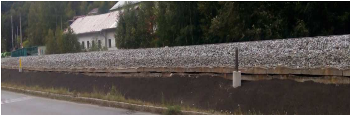
Obrázek 15 Zajišťovací značka umístěná do výškové úrovně kolejnicových pásů s odkrytým betonovým základem
