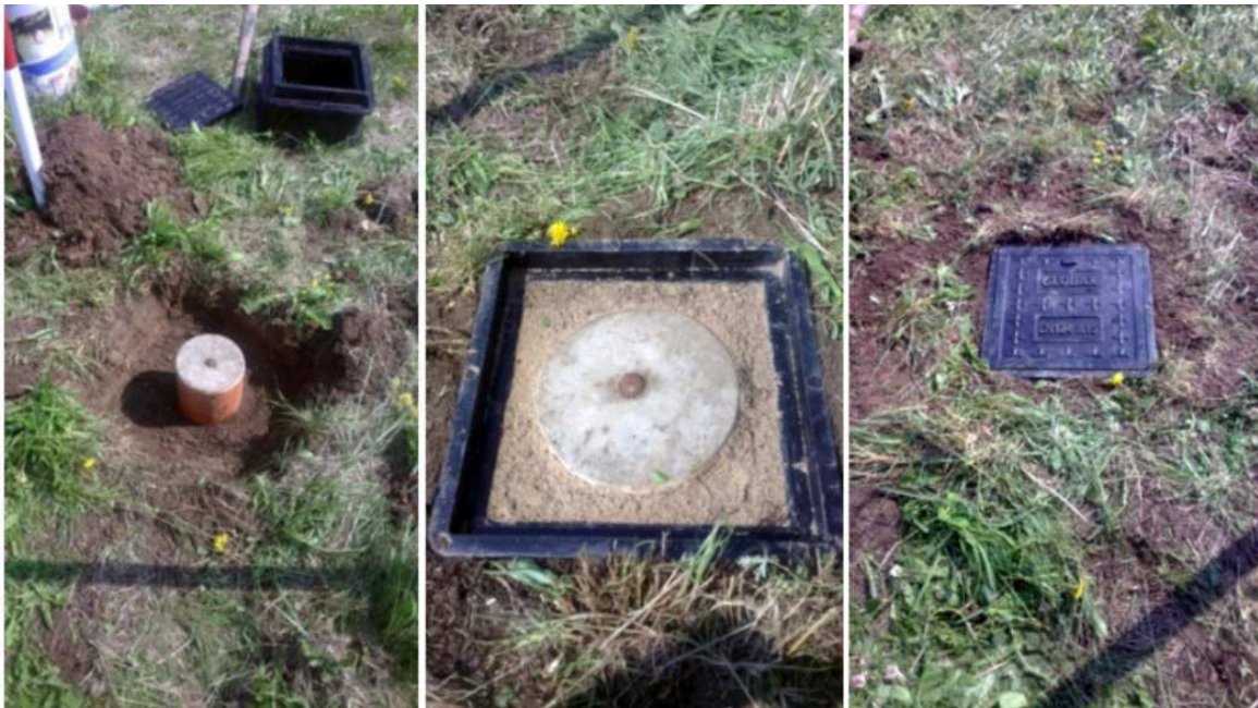
Obrázek 41 Příklad řešení plastové šachty hranaté
