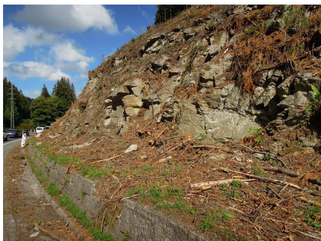
Patní odřezová skalní stěna (km 13,900)
