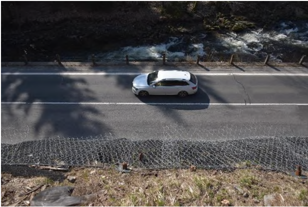
Foto 5 Pohled zpoza hrany sanovaného zářezu v cca km 14,295 (viz foto 10). Hrana zářezu z tohoto pohledu kopíruje krajnici silnice, kde nejsou instalována mobilní betonová svodidla. Tato konfigurace je nepříznivá vůči zadržení skalních objektů uvolněných ze svahu zpoza hrany zářezu.
