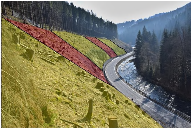
Foto 8 Pohled k J na část vykáceného svahu, který je barevně rozdělen podle v současnosti instalovaných ochranných prvků u paty sanovaného zářezu.
