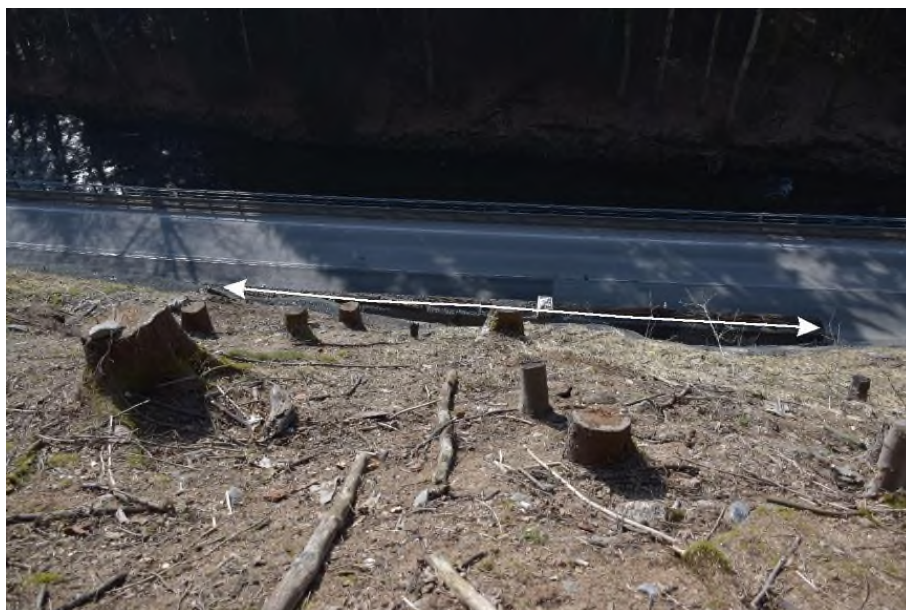
Foto 4 Pohled zpoza hrany sanovaného zářezu v cca km 14,230 (viz foto 8). Bílá linie zvýrazňuje korunu gabionové zdi. Tato konfigurace by měla být účinná k zadržení skalních objektů uvolněných ze svahu zpoza hrany zářezu.
