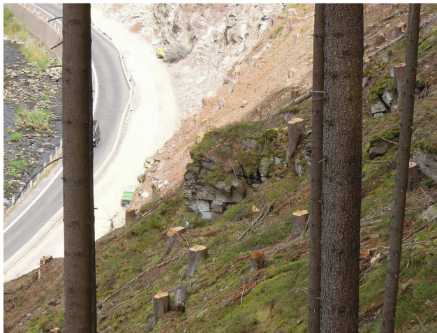
stupňovitý skalní hřebínek na konci úseku (km 14,020)
