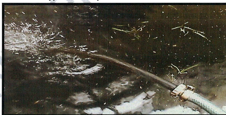
Vypuštění rozpuštěného nánosů z ÚT:
