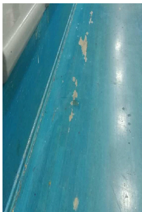
Obr.2 Poškození laku
