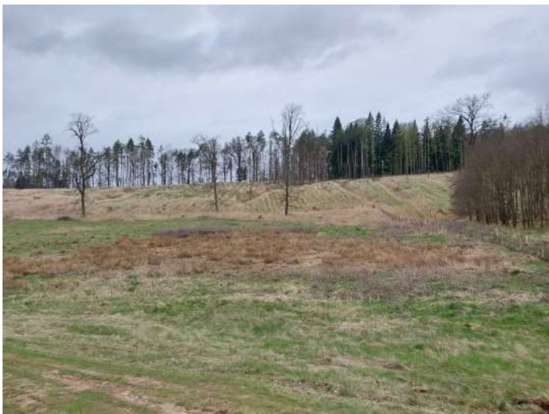
Horní louka se zatrubněním nad cestou, počátek řešeného úseku
