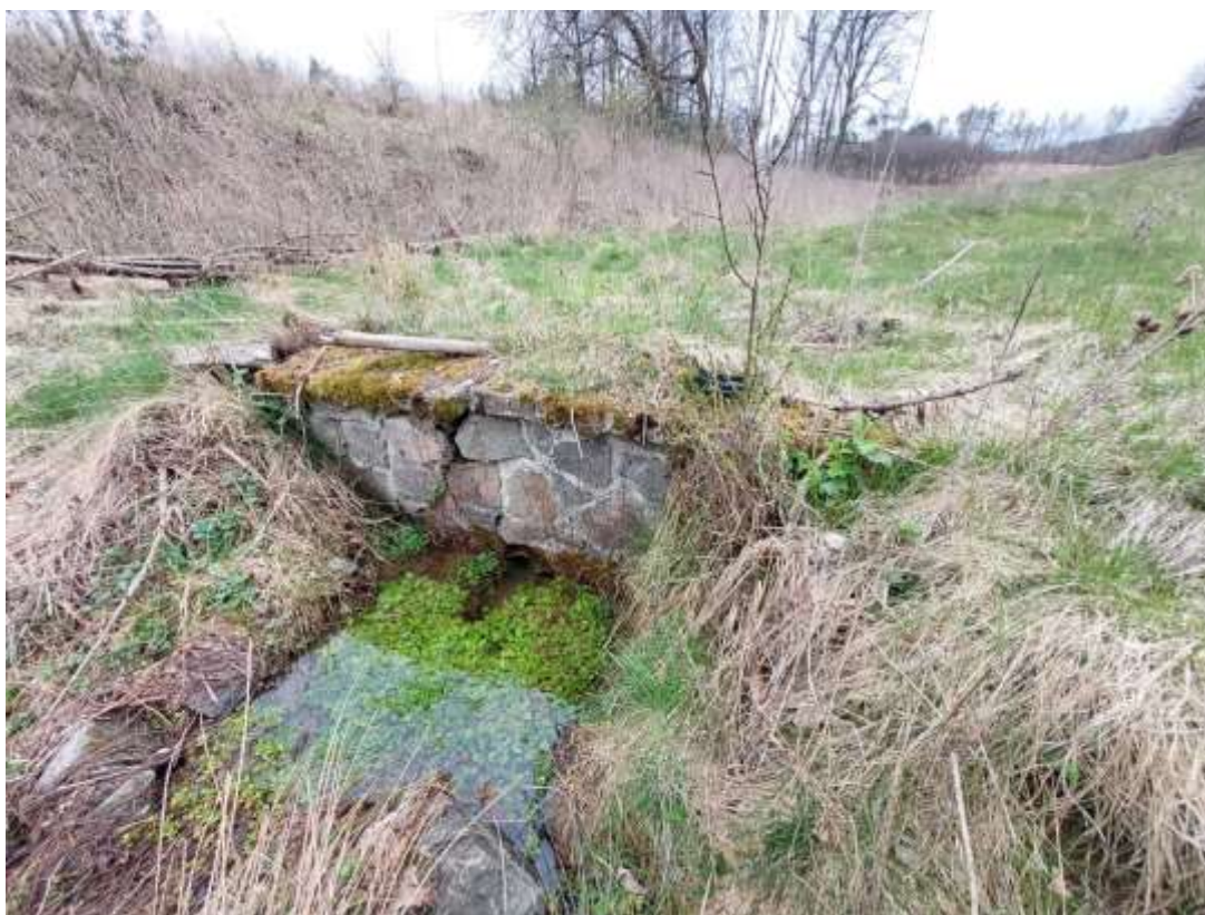
Vyústní čelo, konec zatrubnění, konec řešeného úseku
