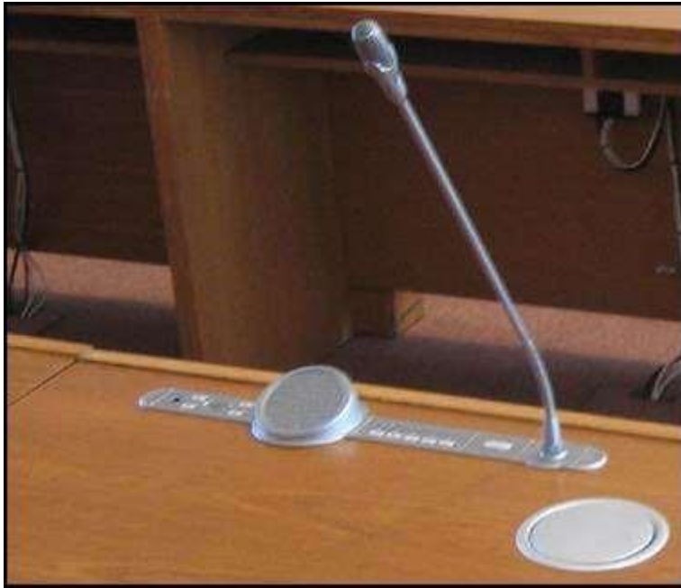
Obrázek 1. Stávající vestavná jednotka.
