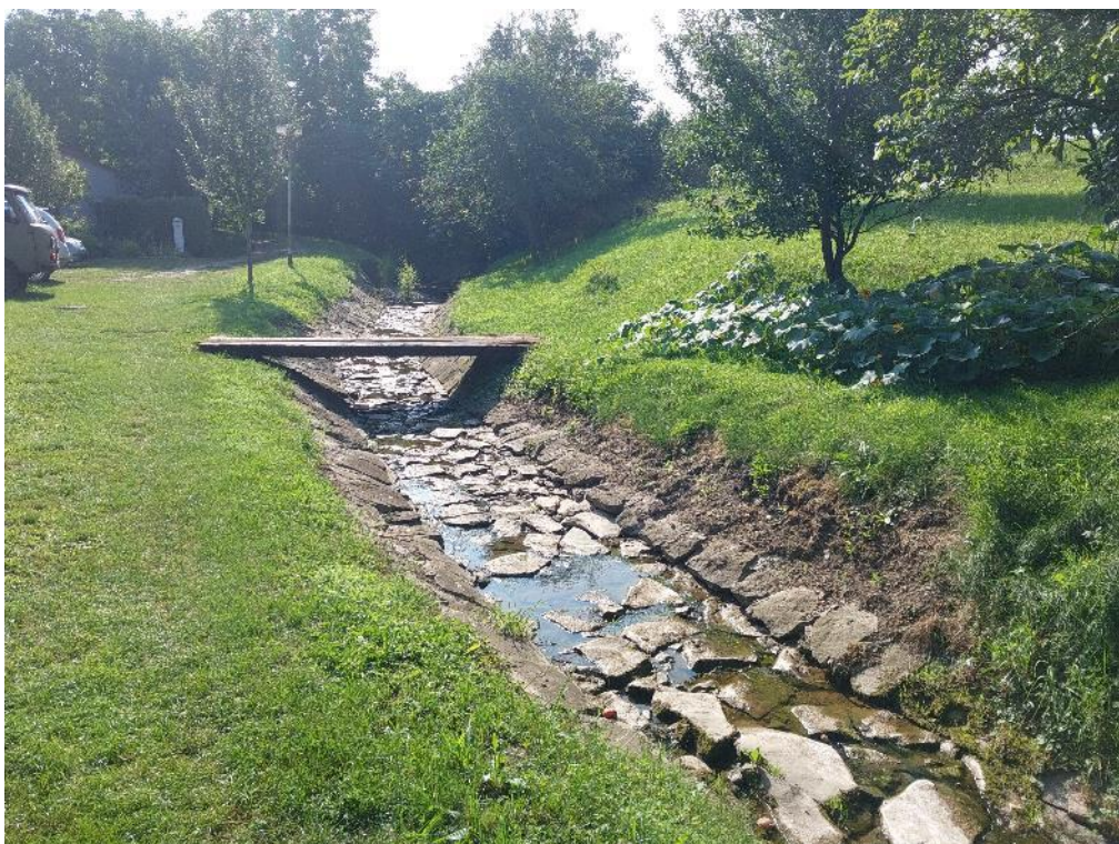
1 Současný stav koryta VT Žopka v km 1,8 (foto proti proudu)
