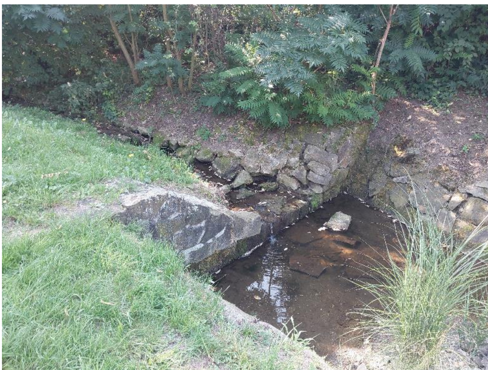
4 Současný stav koryta VT Žopka v km 1,84 (foto rozpadající vodní stupeň)
