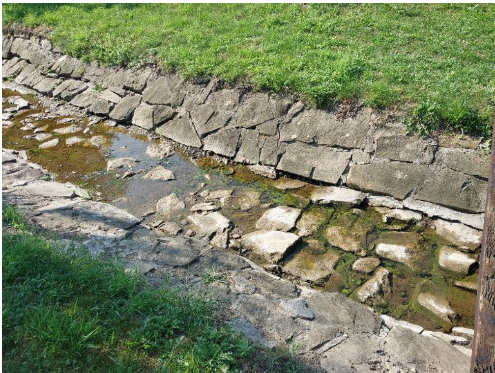
3 Současný stav kamenné dlažby VT Žopka (pohled proti proudu na kamennou dlažbu) ř.km. 18,1
