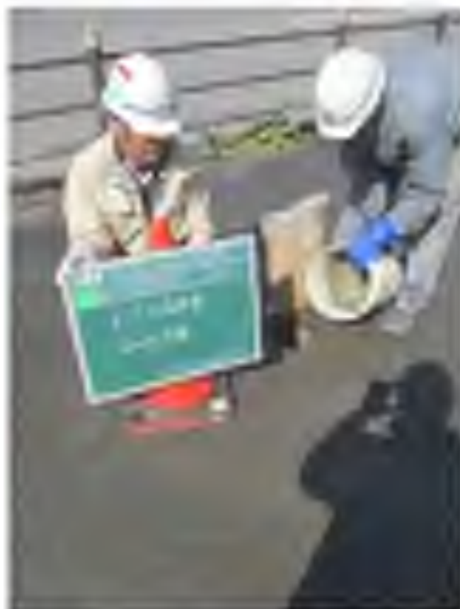
No. 5 調査孔閉塞 (モルタル充填)
