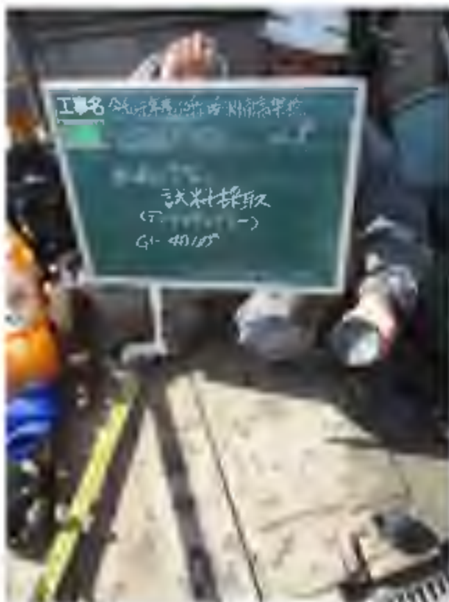
No. 5 乱れの少ない試料採取 (デニソンサンプリング) GL-40.00~40.70m
