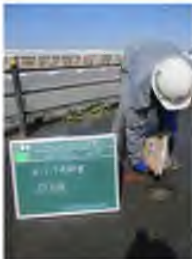
No. 5 調査孔閉塞 (砂充填)
