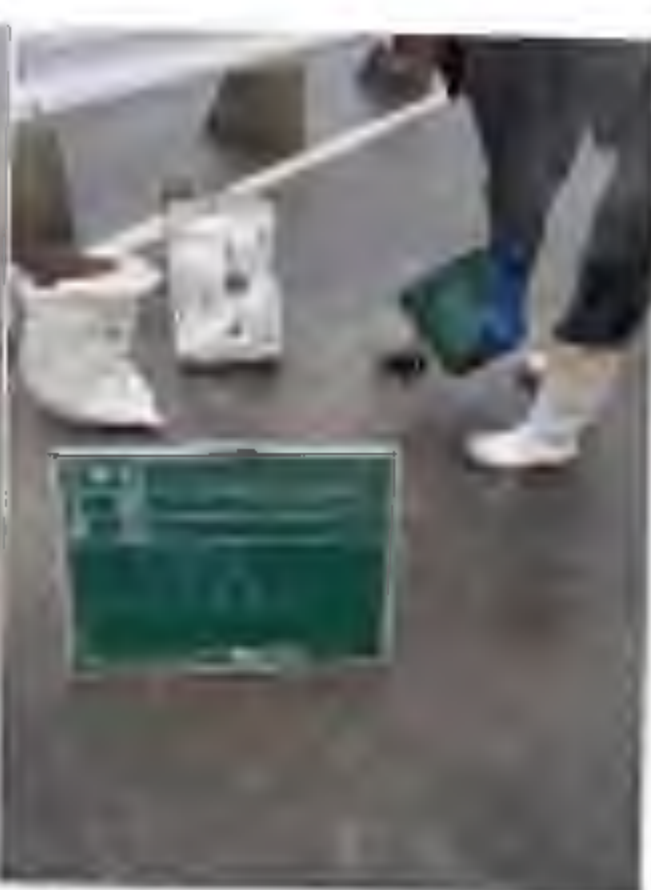
No. 1 調査孔閉塞 (モルタル充填)
