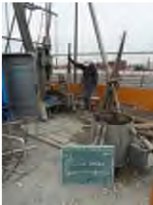
No. 3 乱れの少ない試料採取 (デニソンサンプリング)
