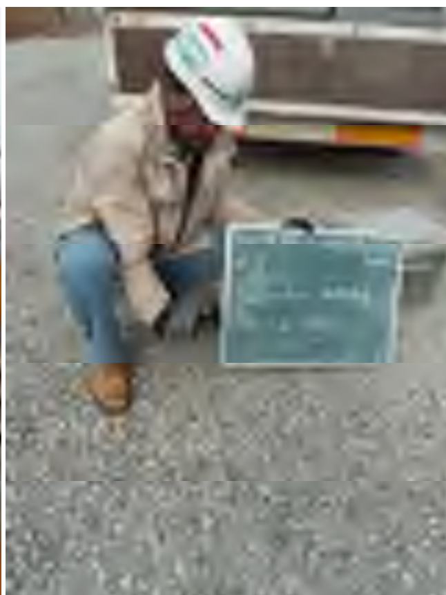
No. 3 乱れの少ない試料採取 (トリプルサンプリング) GL-3. 80~4. 80m
