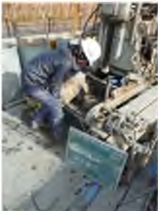
No. 2 調査孔閉塞 (砂充填)
