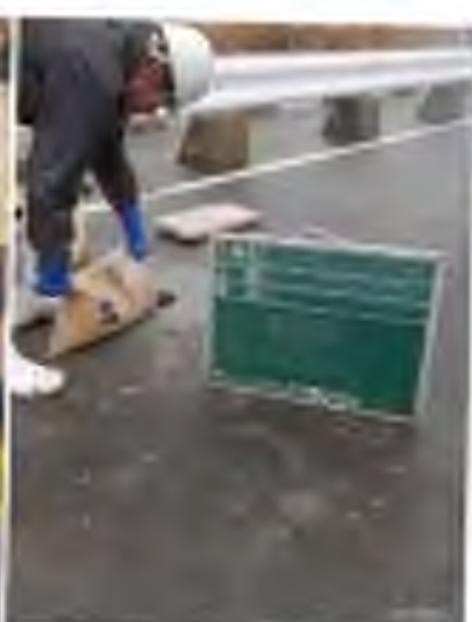
No. 1 調査孔閉塞 (砂充填)
