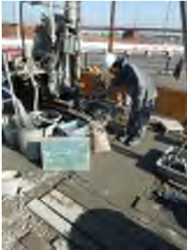
No. 3 調査孔閉塞 (砂充填)
