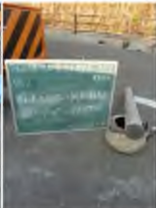
No. 2 乱れの少ない試料採取 (デニソンサンプリング) GL-89, 00~89, 75m
