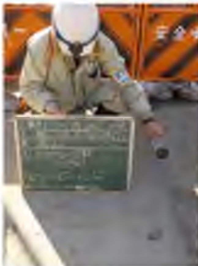
No. 1 乱れの少ない試料採取 (トリプルサンプリング) GL-61. 50~62. 50m
