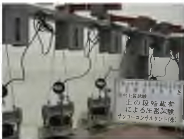
室内土質試験 土の段階的荷重による圧密試験
