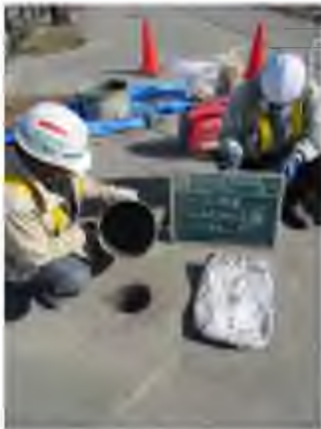
No. 4 調査孔閉塞 (セメントモルタル充填)
