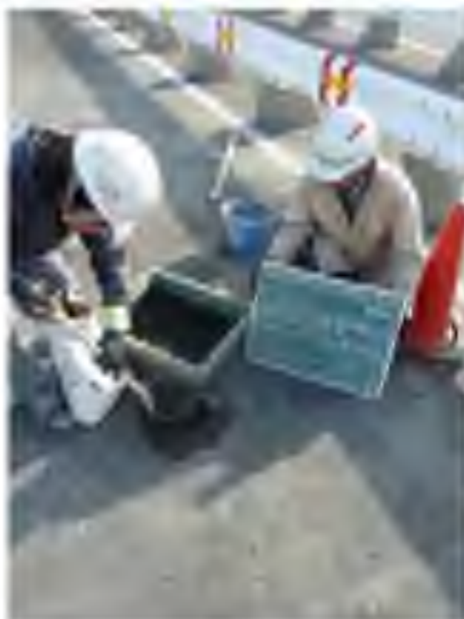
No. 2 調査孔閉塞 (セメントモルタル埋め戻し)
