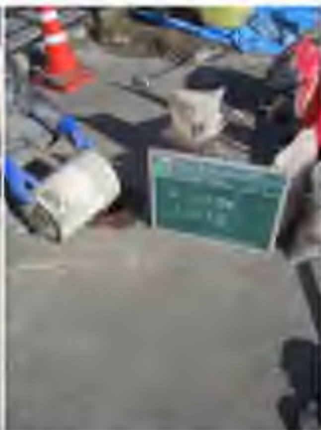
No. 4 調査孔閉塞 (モルタル充填)
