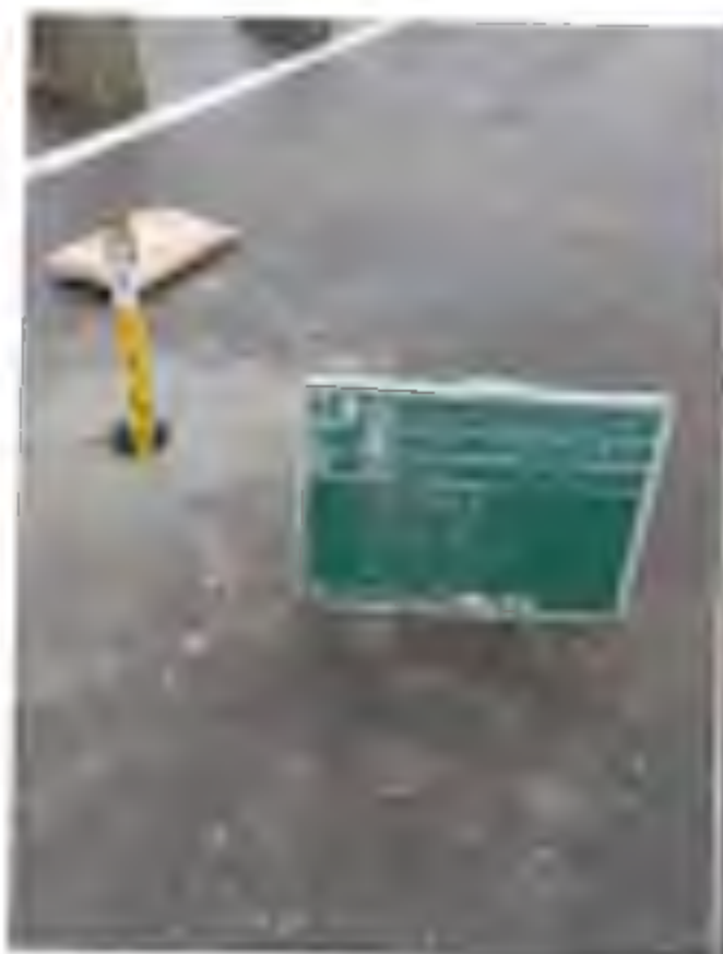
No. 1 調査孔閉塞 (砂充填完了 GL-0.75m)
