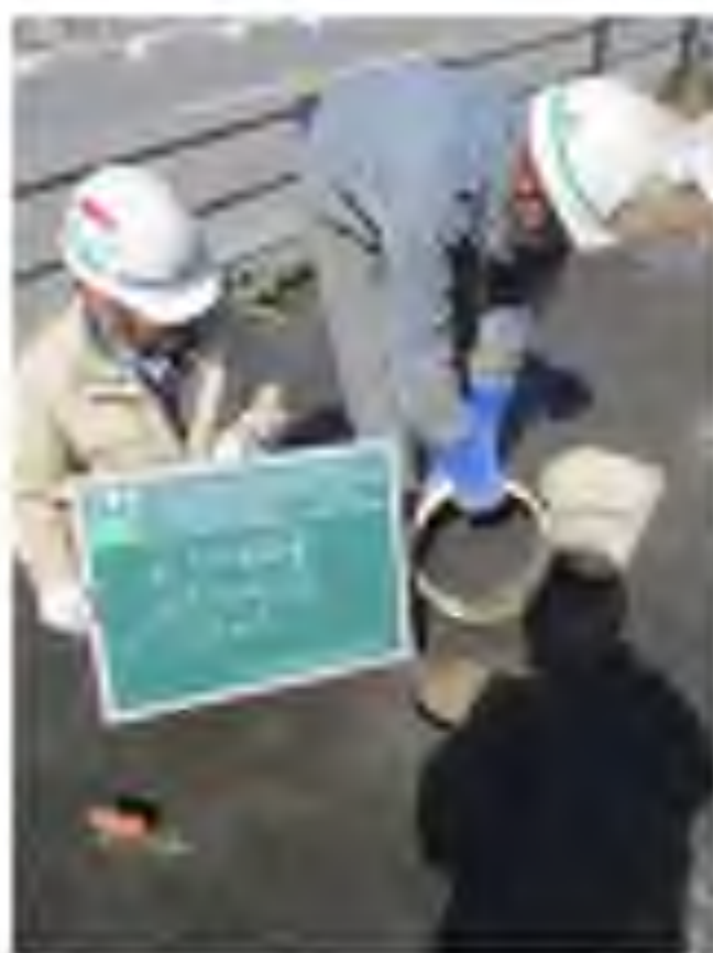
No. 5 調査孔閉塞 (モルタル充填)
