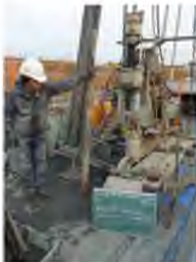
No. 2 乱れの少ない試料採取 (トリプルサンプリング)
