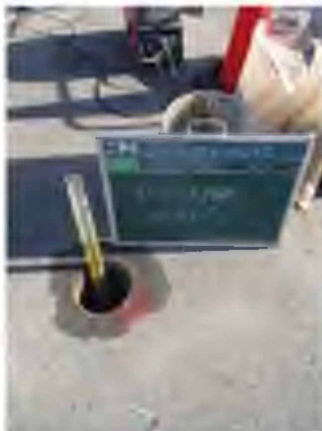
No. 4 調査孔閉塞 (砂充填完了 GL-0.75m)
