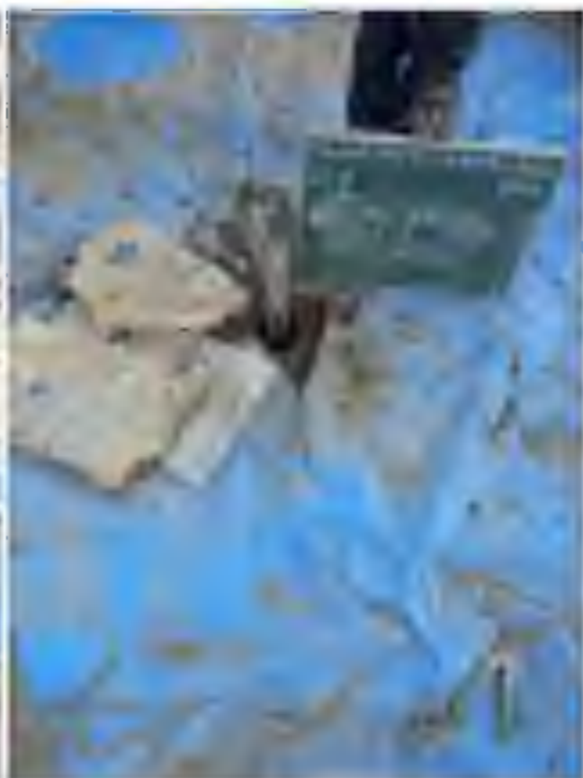
No. 2 調査孔閉塞 (砂充填 GL-0.75mまで)
