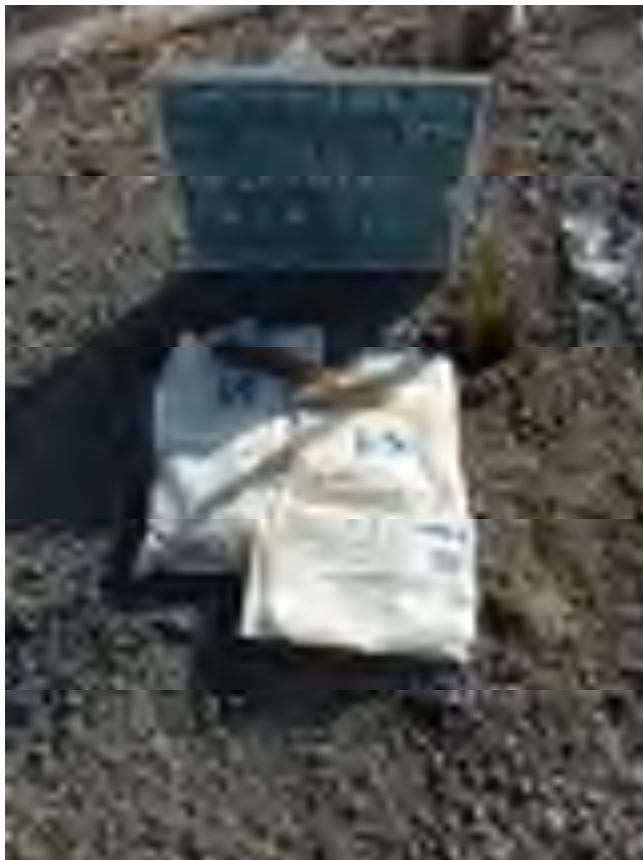
No. 3 調査孔閉塞 (砂充填 GL-0.75mまで)
