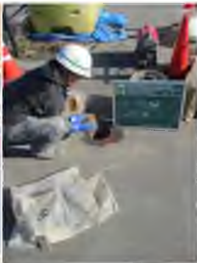
No. 4 調査孔閉塞 (砂充填)
