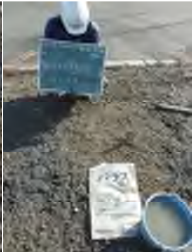
No. 3 調査孔閉塞 碎石充填 0.75m
