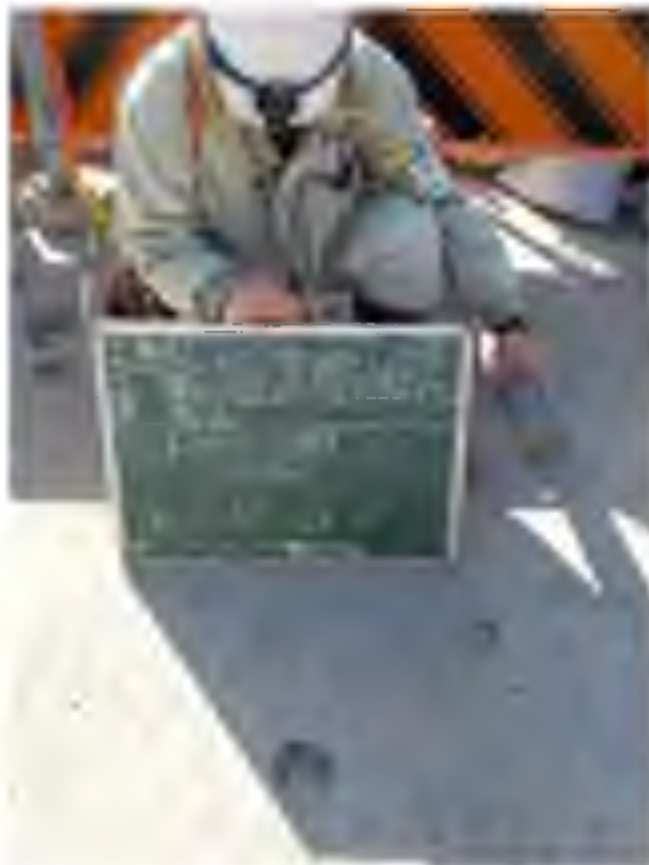
No. 1 乱れの少ない試料採取 (トリプルサンプリング) GL-63.50~64.50m
