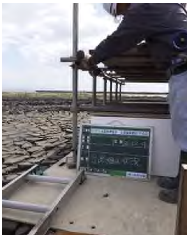
足場仮設状況
