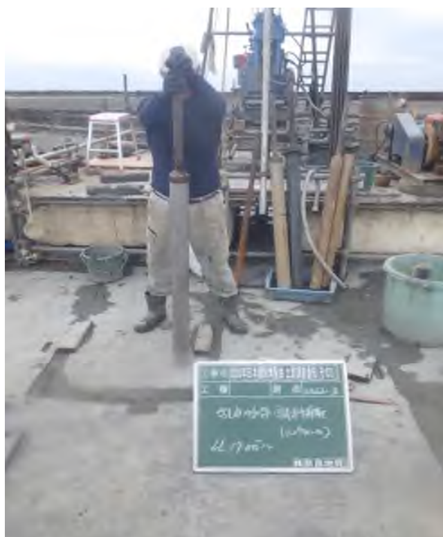
乱れの少ない試料採取（シンウォールサンプリング） (17.00~17.80m)
