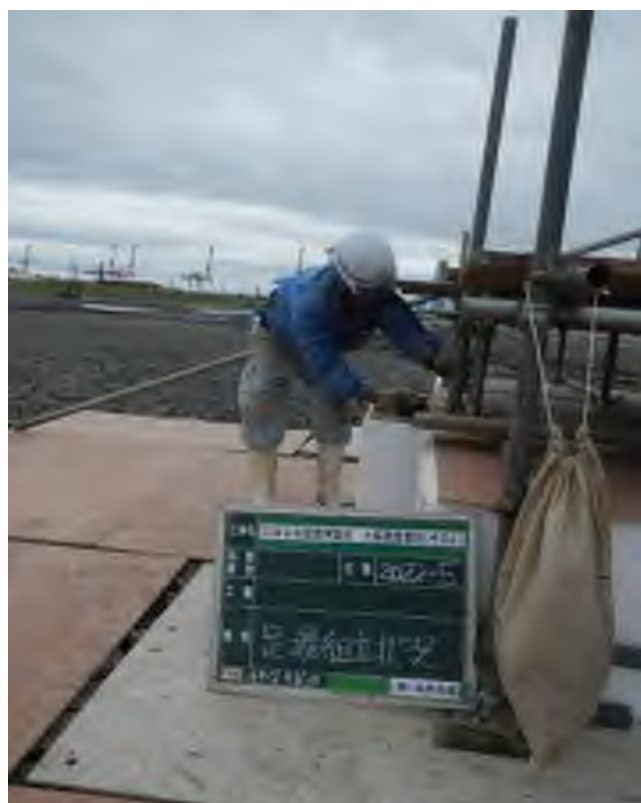
足場仮設状況
