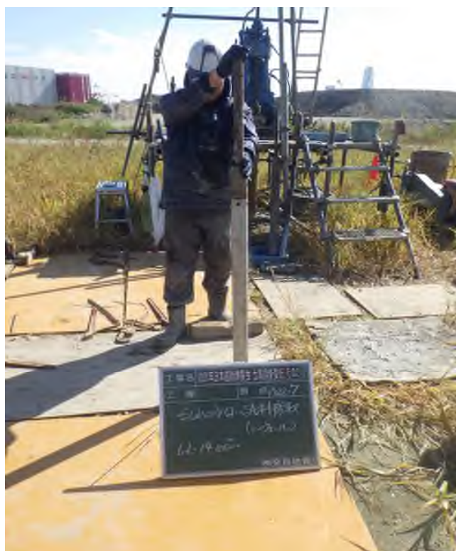
乱れの少ない試料採取 (シンウォールサンプリング) (14.00~14.65m)
