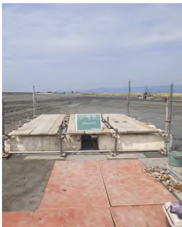
足場仮設状況
