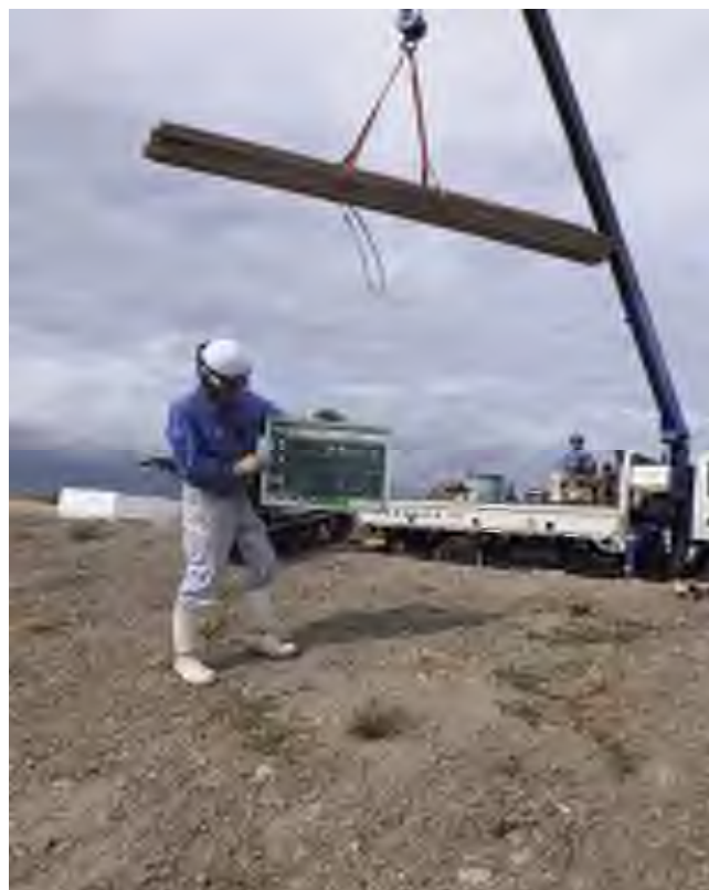
搬入出状況(車載クレーン)
