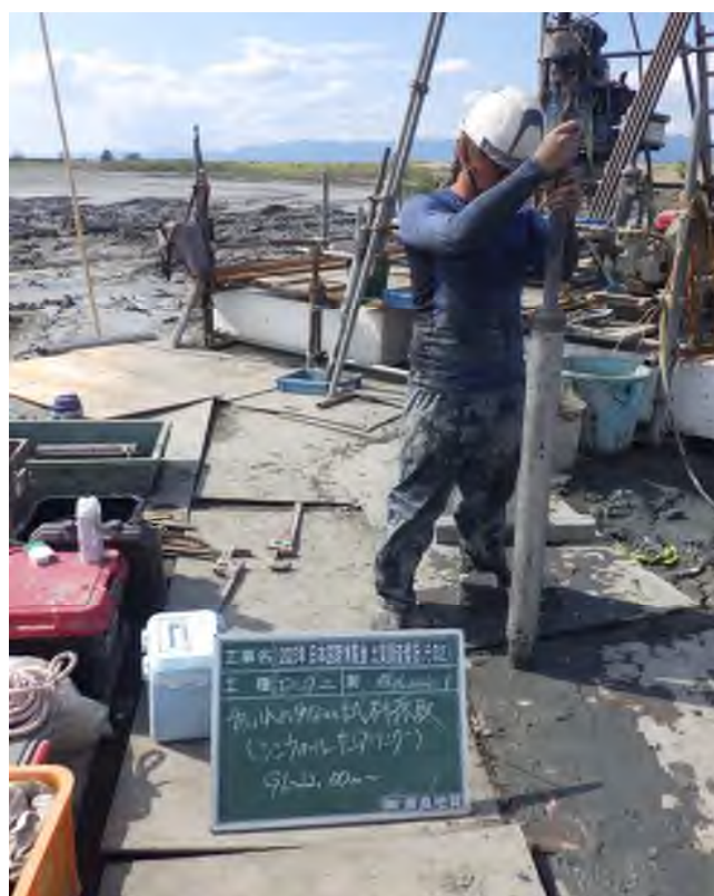
乱れの少ない試料採取（シンワールサンプリング） (21.00～21.90m)
