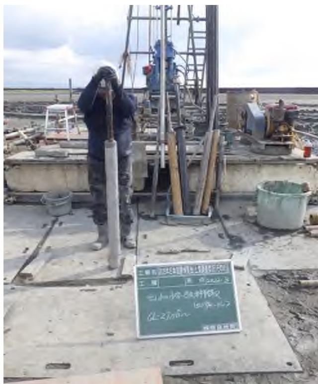
乱れの少ない試料採取（シンウォールサンプリング） (27.00～27.60m)
