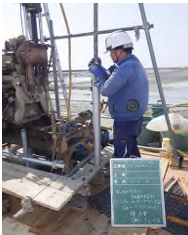
乱れの少ない試料採取（シンウォールサンプリング） (1.00~1.80m)
