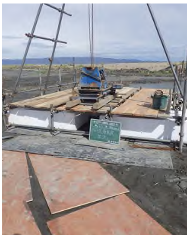
足場仮設状況
