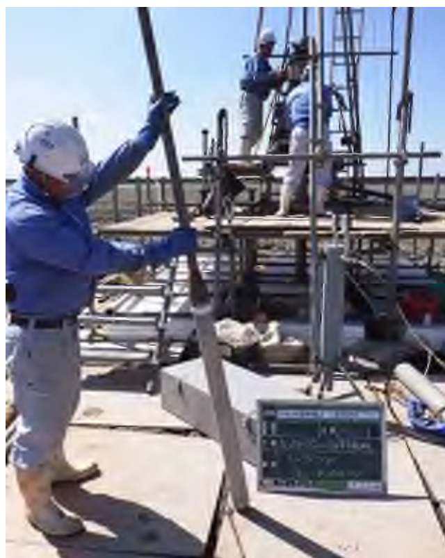
乱れの少ない試料採取（シンウォールサンプリング） (3.00～3.89m)
