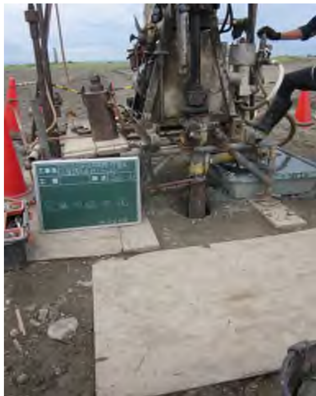
足場仮設状況
