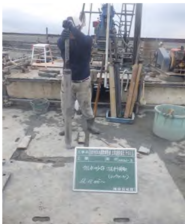
乱れの少ない試料採取（シンウォールサンプリング） (17.00~17.80m)
