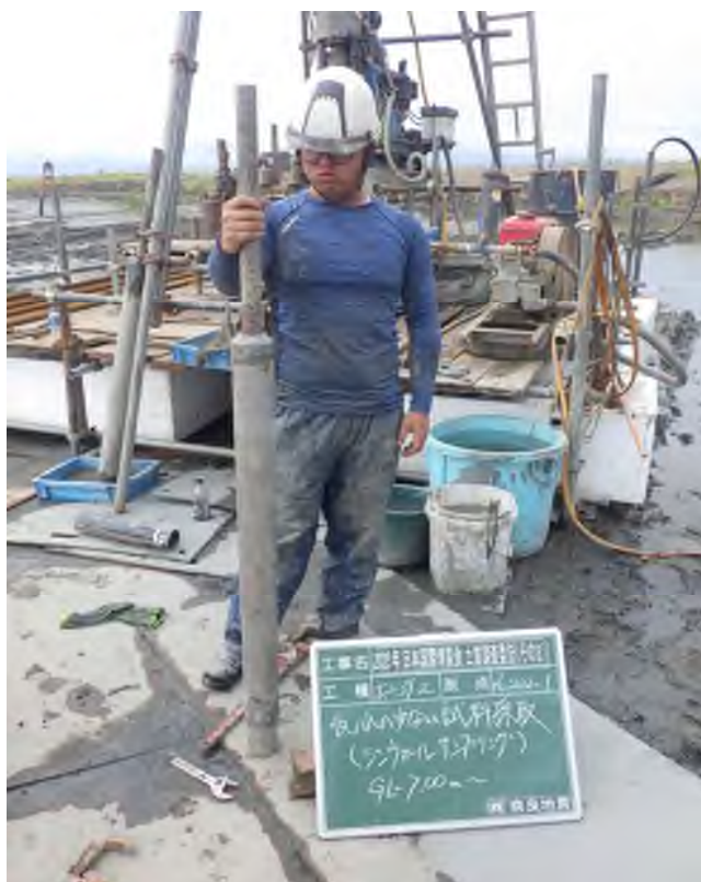
乱れの少ない試料採取（シンウォールサンプリング） (7.00~7.90m)
