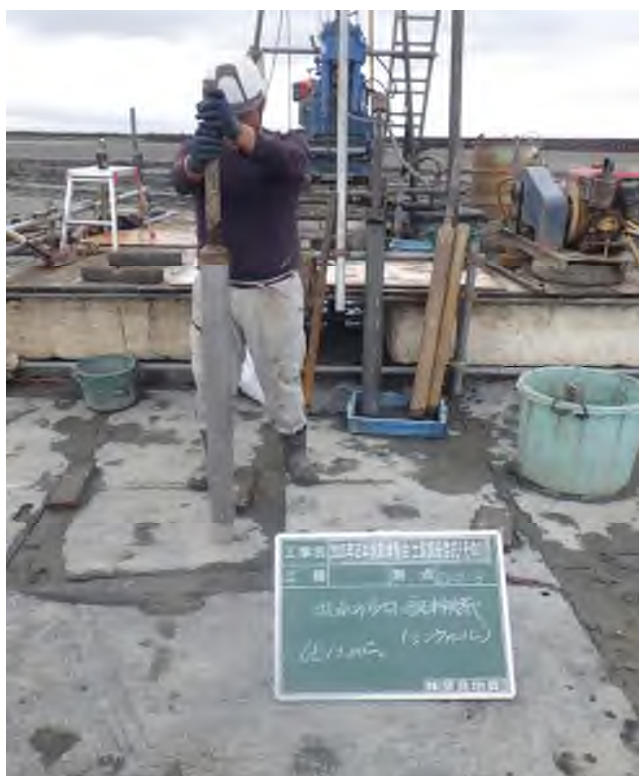
乱れの少ない試料採取（シンウォールサンプリング） (13.00～13.80m)
