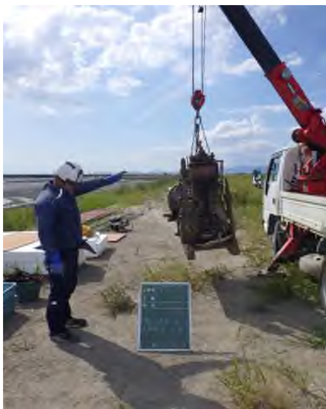
搬入出状況(車載クレーン)
