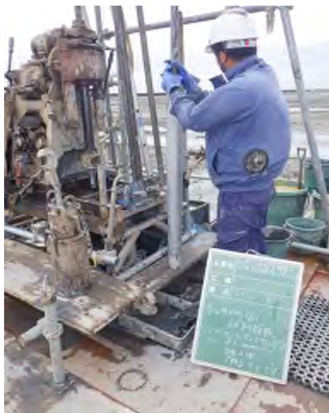
乱れの少ない試料採取（シンウォールサンプリング） (20.00～20.85m)
