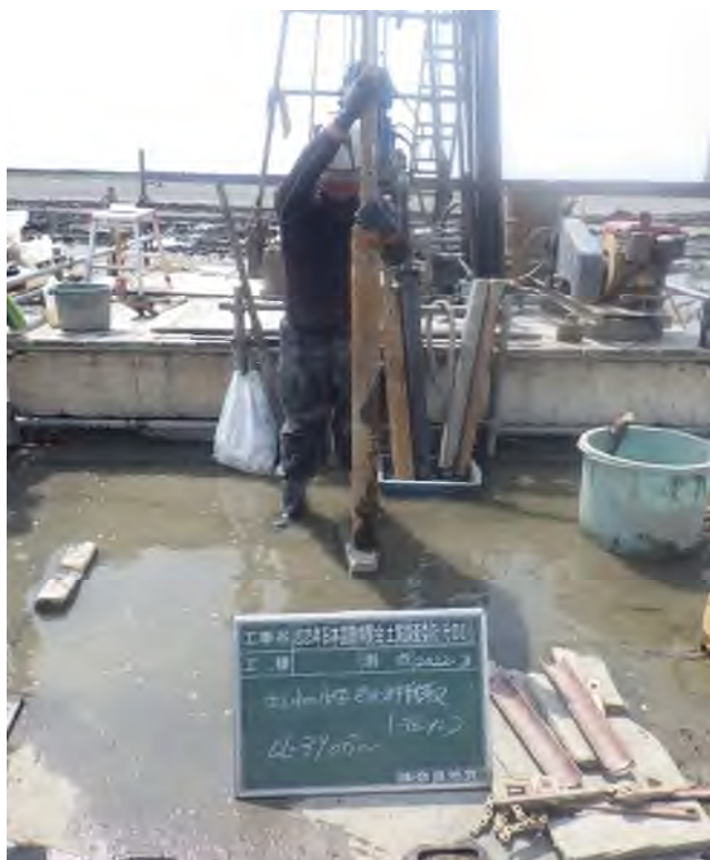
乱れの少ない試料採取（デニソンサンプリング） (39.00～39.45m)
