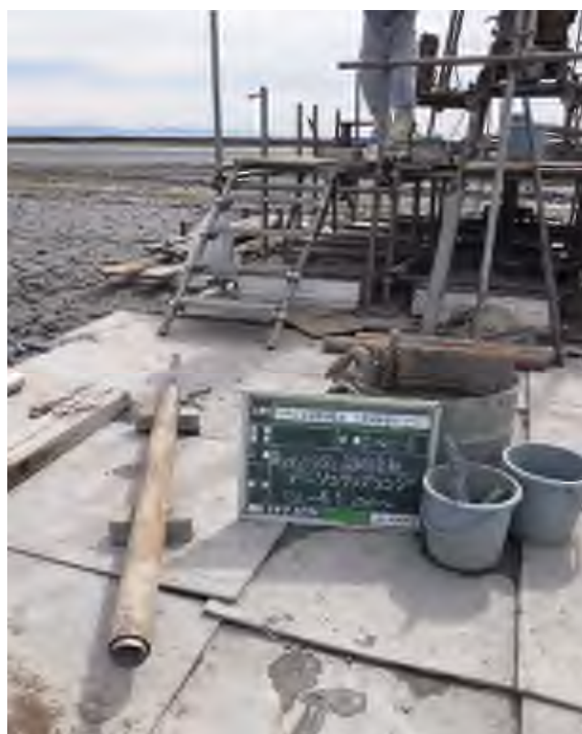
乱れの少ない試料採取（デニソンサンプリング） (38.00～38.40m)
