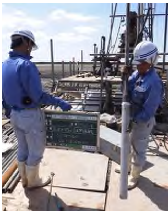
乱れの少ない試料採取（シンウォールサンプリング） (5.00～5.89m)
