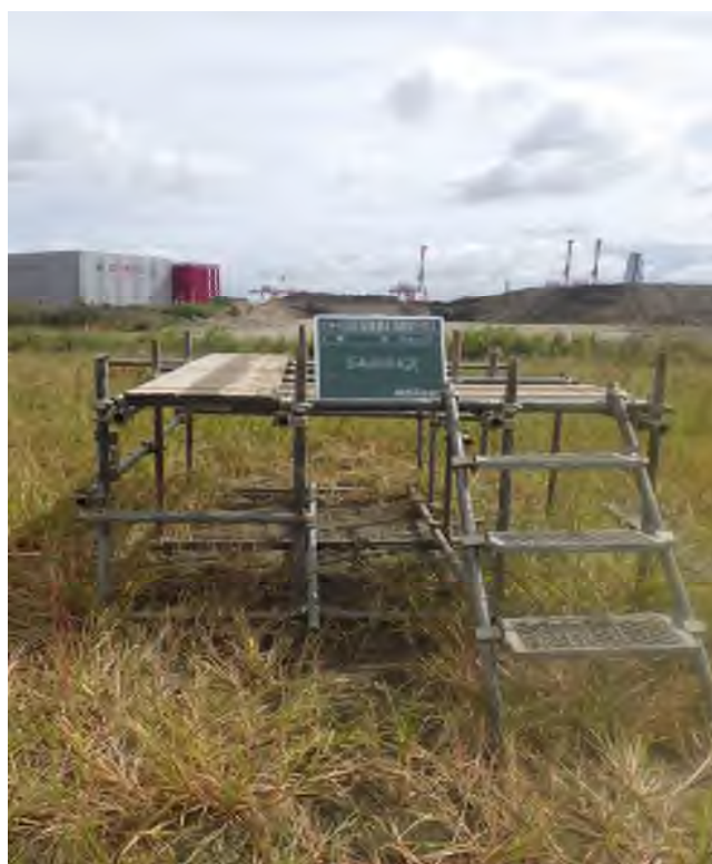
足場仮設状況
