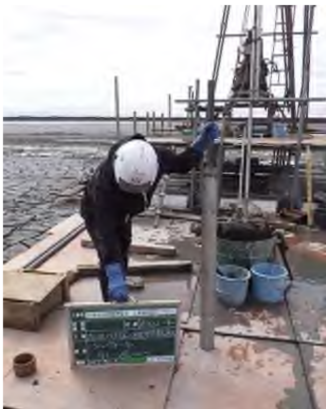
乱れの少ない試料採取（シンウォールサンプリング） (15.00～15.80m)
