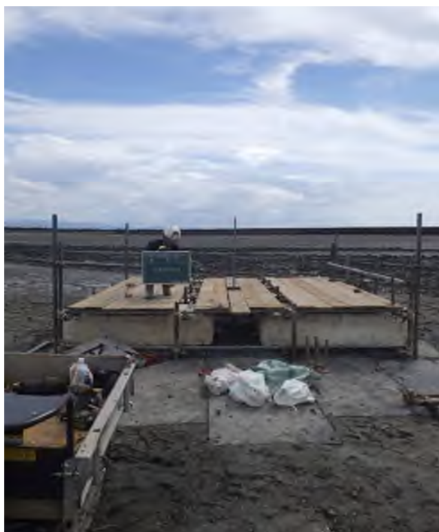
足場仮設状況
