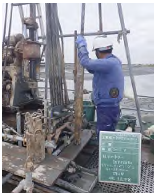
乱れの少ない試料採取（デニソンサンプリング） (35.00～35.40m)
