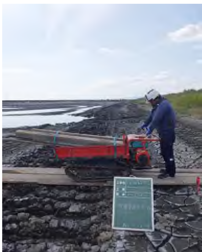
搬入出状況(クローラー運搬)
