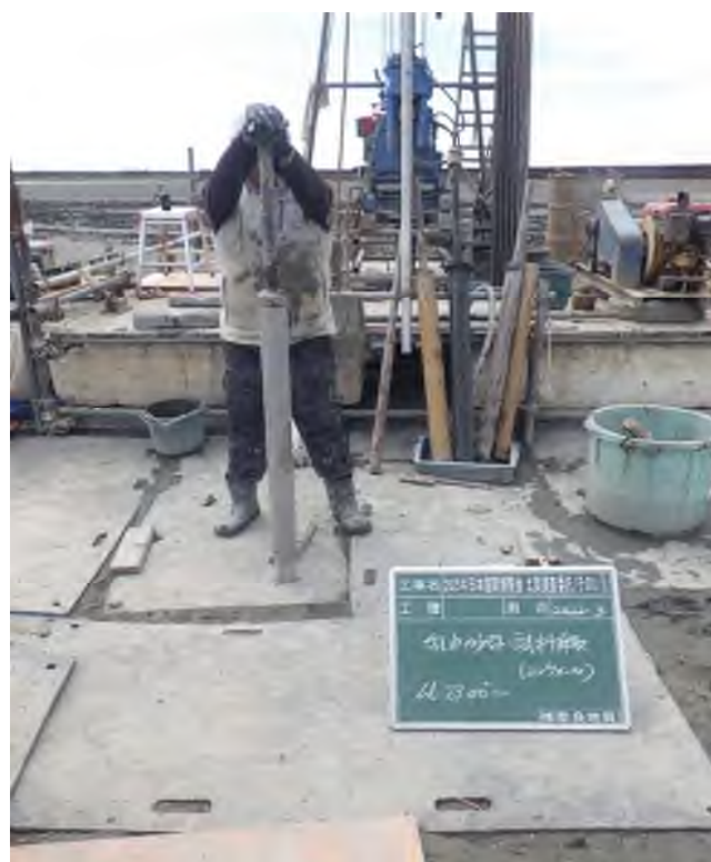
乱れの少ない試料採取（シンウォールサンプリング） (22.00～22.80m)
