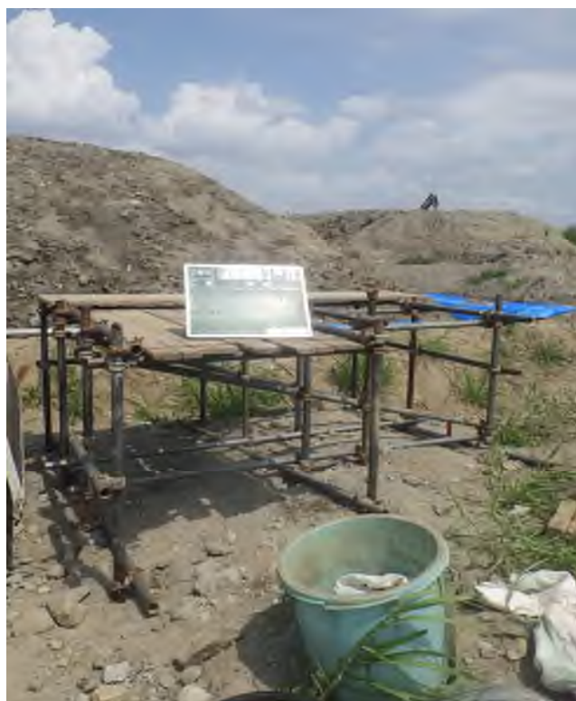
足場仮設状況
