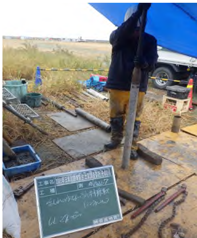
乱れの少ない試料採取（シンウォールサンプリング） (23.00～23.55m)
