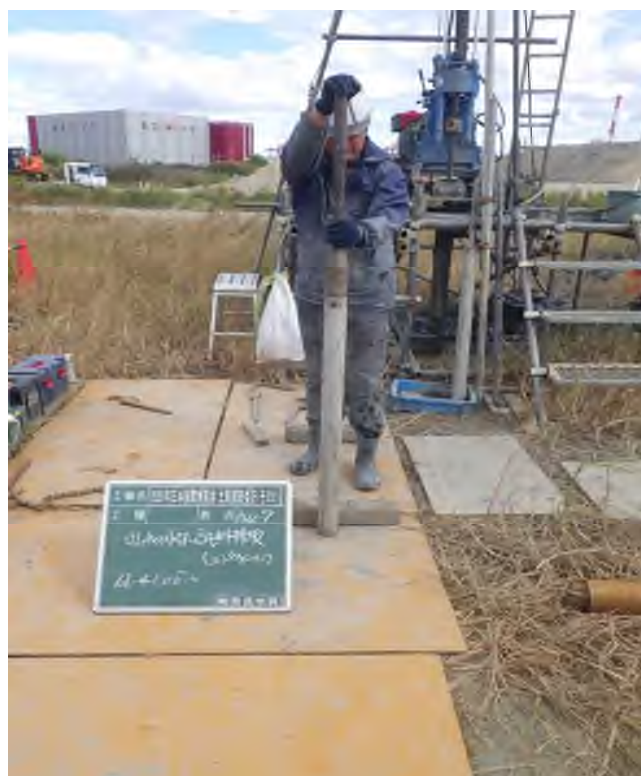
乱れの少ない試料採取（シンウォールサンプリング） (38.00～38.65m)
