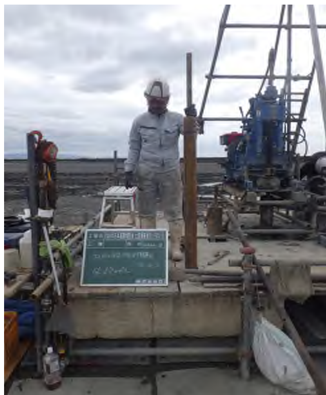
乱れの少ない試料採取（デニソンサンプリング） (45.00～45.45m)
