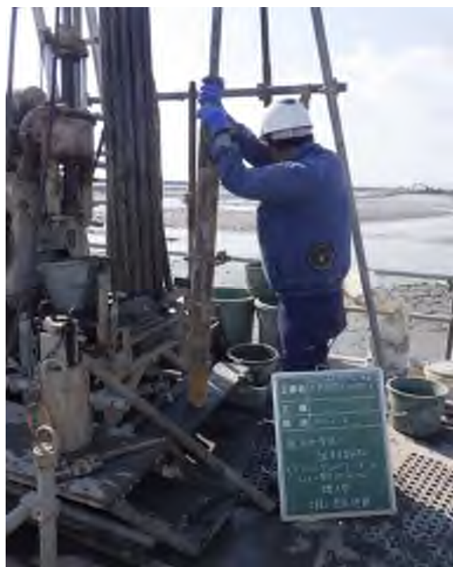
乱れの少ない試料採取（デニソンサンプリング） (47.00～47.45m) (57.00～57.75m)
