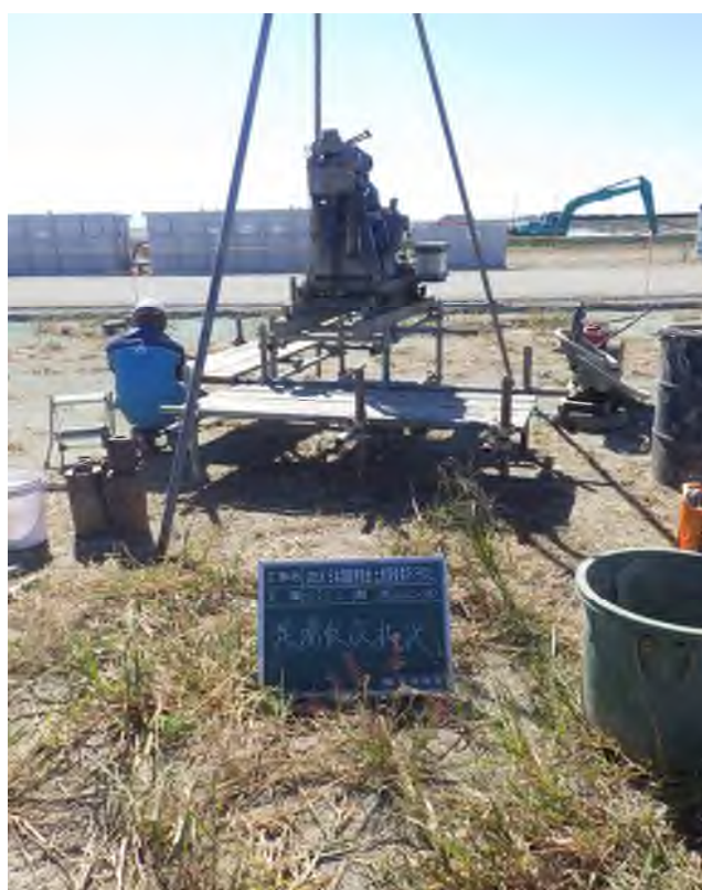
足場仮設状況
