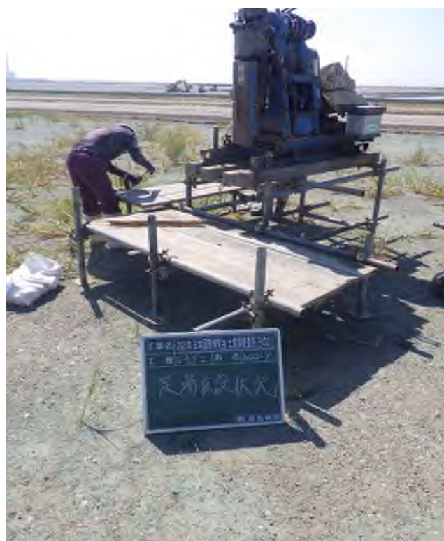
足場仮設状況
