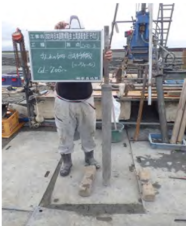
乱れの少ない試料採取（シンウォールサンプリング） (7.00～7.80m)
