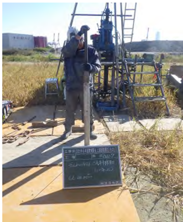
乱れの少ない試料採取（シンウォールサンプリング） (19.00～19.55m)
