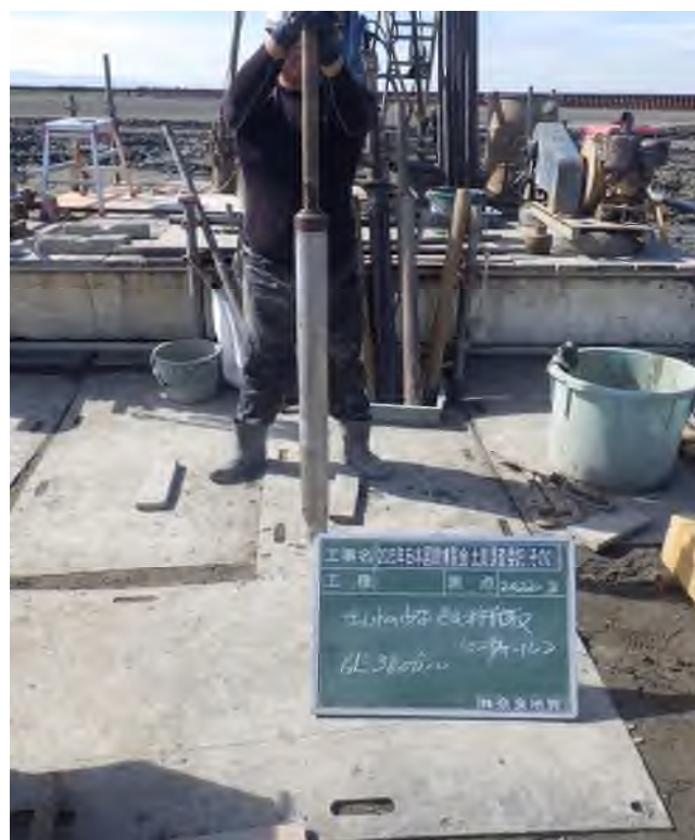
乱れの少ない試料採取（シンウォールサンプリング） (27.00～27.60m)
