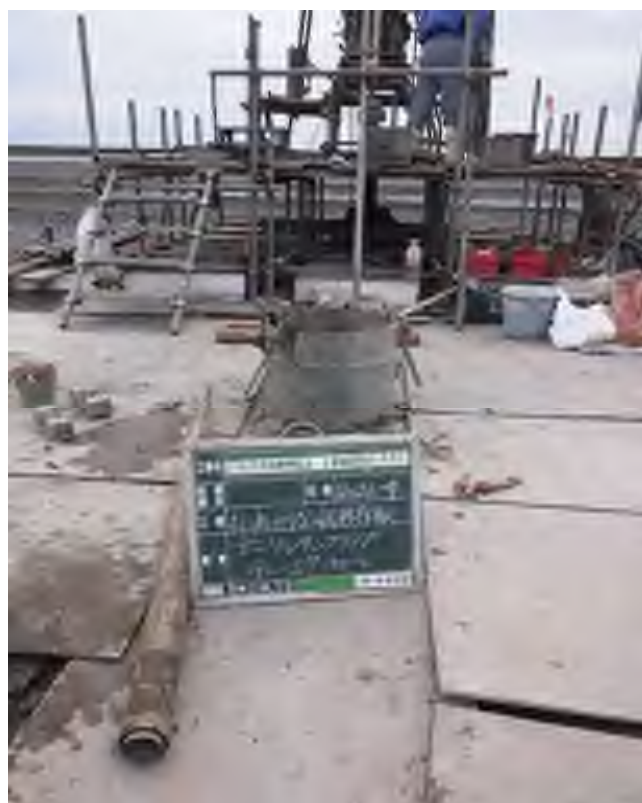
乱れの少ない試料採取（デニソンサンプリング） (44.00～44.55m) (57.00～57.75m)
