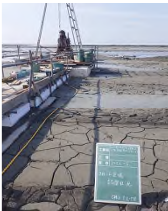
フロート足場設置状況
