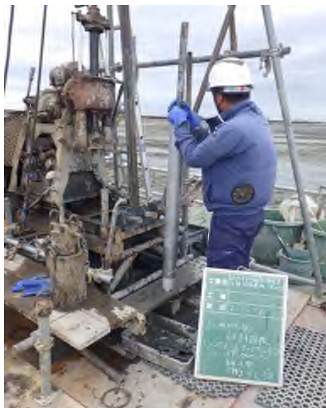
乱れの少ない試料採取（シンウォールサンプリング） (18.00～18.70m)
