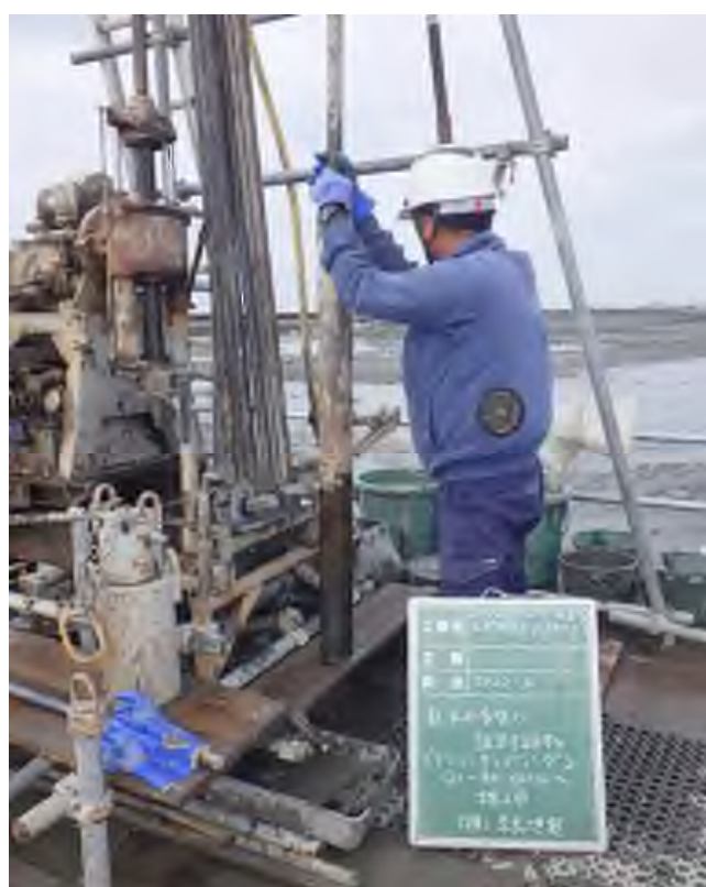
乱れの少ない試料採取（デニソンサンプリング） (41.00～41.50m)
