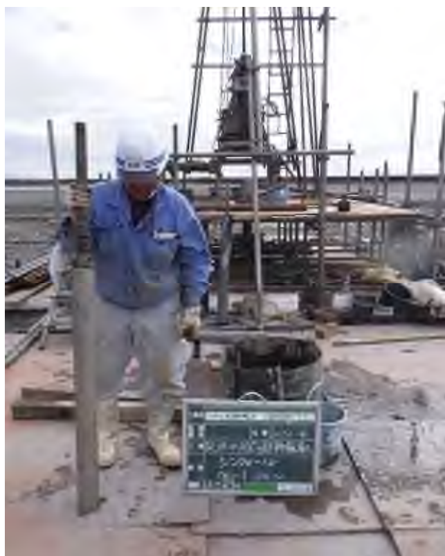
乱れの少ない試料採取（シンウォールサンプリング） (11.00～11.77m) (12.00～12.77m)
