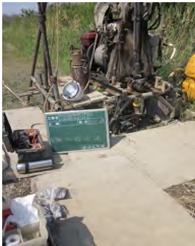
足場仮設状況
