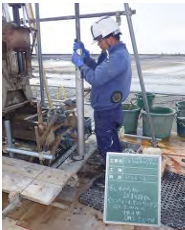
乱れの少ない試料採取（シンウォールサンプリング） (5.00～5.90m)
