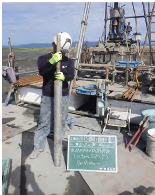
乱れの少ない試料採取（シンウォールサンプリング） (11.00～11.90m)
