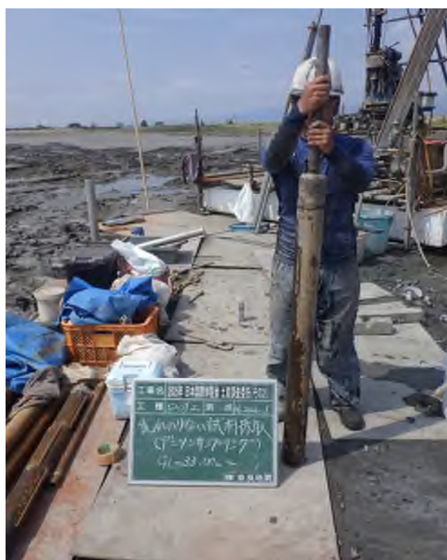
乱れの少ない試料採取（デニソンサンプリング） (30.00～30.80m)
