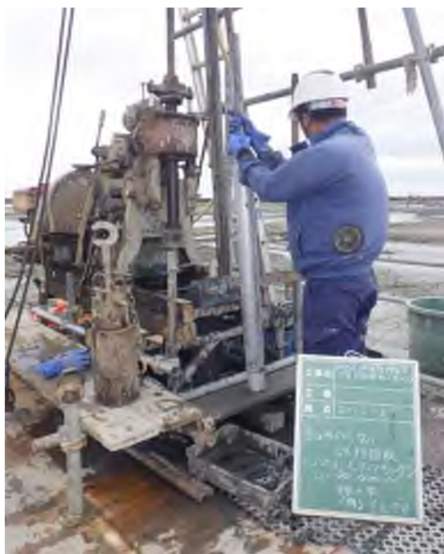
乱れの少ない試料採取（シンウォールサンプリング） (20.00～20.85m)
