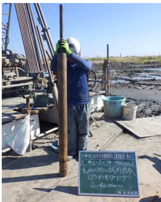
乱れの少ない試料採取（デニソンサンプリング） (42.00～42.50m)
