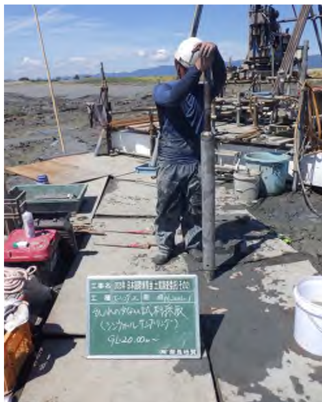
乱れの少ない試料採取（シンワールサンプリング） (19.00～19.90m)
