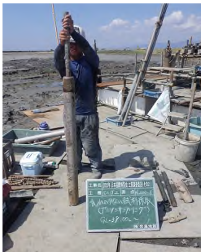
乱れの少ない試料採取（デニソンサンプリング） (36.00～36.90m)
