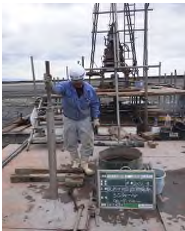
乱れの少ない試料採取（シンウォールサンプリング） (9.00～9.75m)
