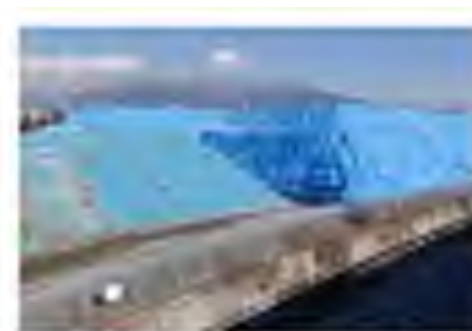
（面的措置）ブルーシート被覆
