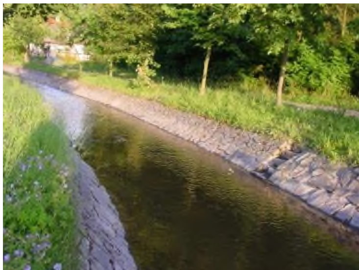
Obr. 26: Kamenná dlažba do betonu (vlevo), vegetační tvárnice (vpravo), v obou případech se jedná o stabilní profil bez známek břehové eroze (vliv úprav koryta a jejich udržování) – viz parametr 5
