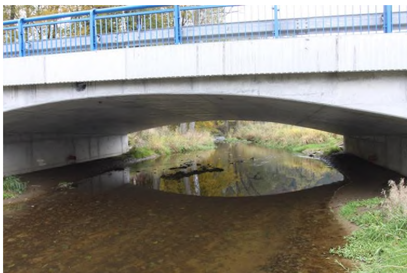
Obr. 49: Most s břehovými naplaveninami a přirozeným dnem je plně průchodný pro vydru i další semiakvatické druhy. Je plně průchodný i pro všechny druhy ryb.
