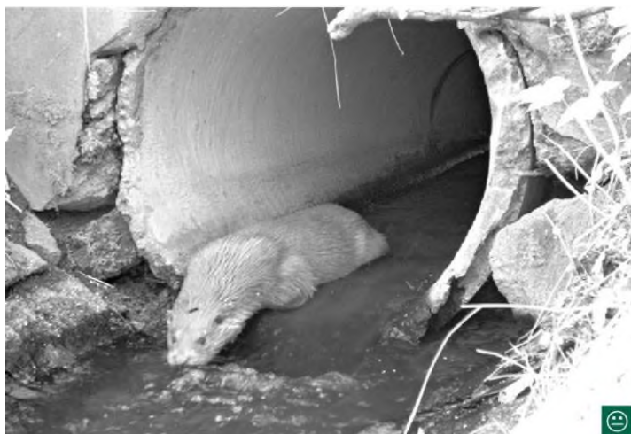
Obr. 50: Trubní propustky s malou hloubkou vody jsou pro vudru průchodné
