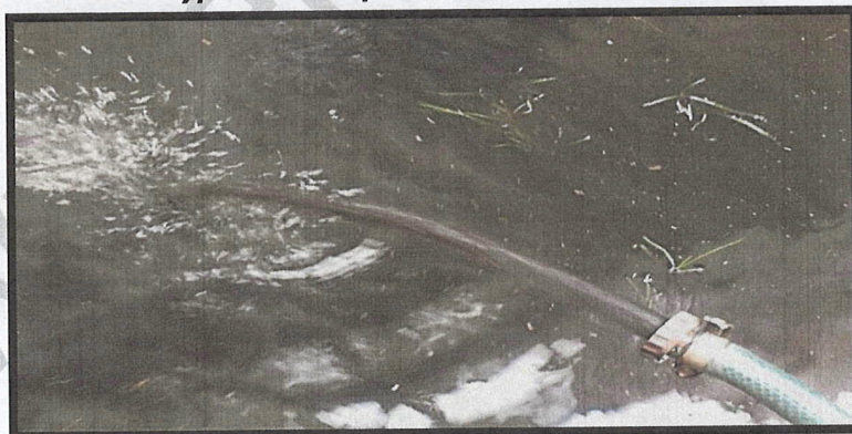
Vypuštění rozpuštěného nánosů z ÚT:
