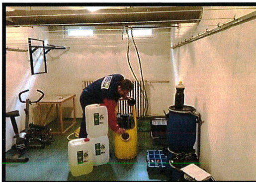
Připojení zařízení ke stoupačím potrubí:
