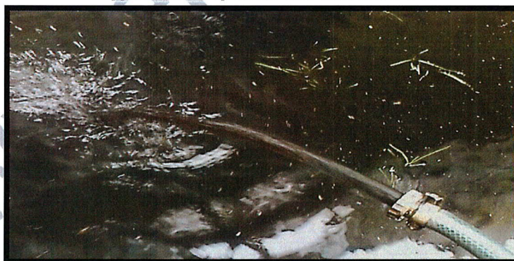
Vypuštění rozpuštěného nánosů z ÚT:
