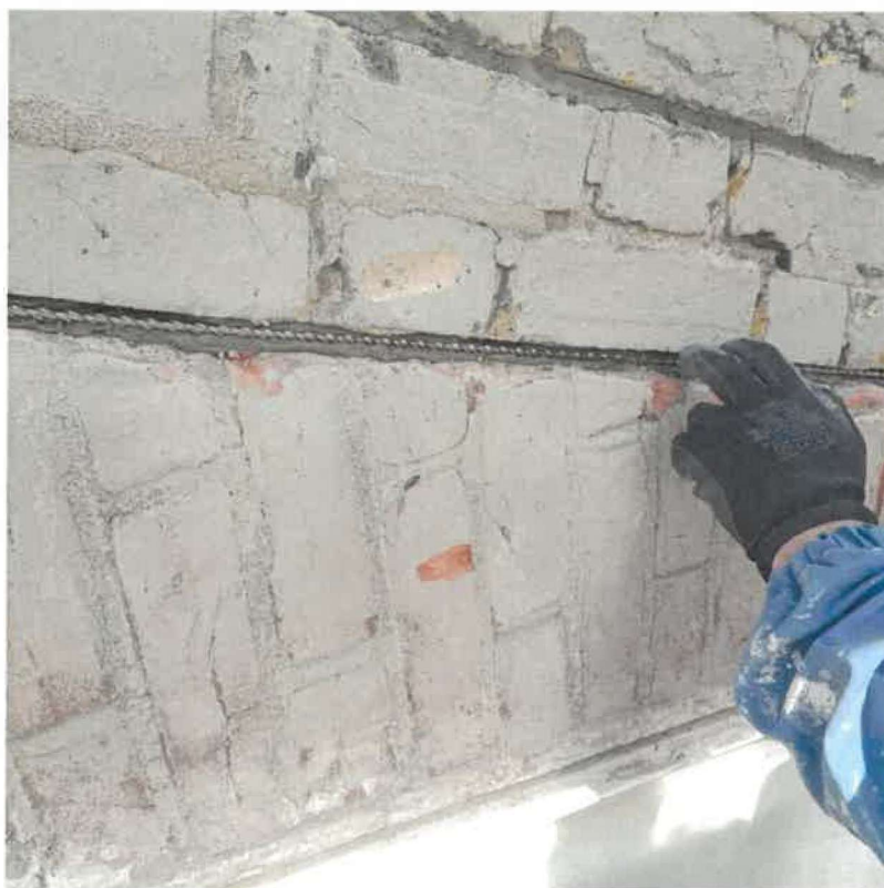
Foto 05 – detail osazování helikální výztuže pro sešití zdiva v místě trhliny
