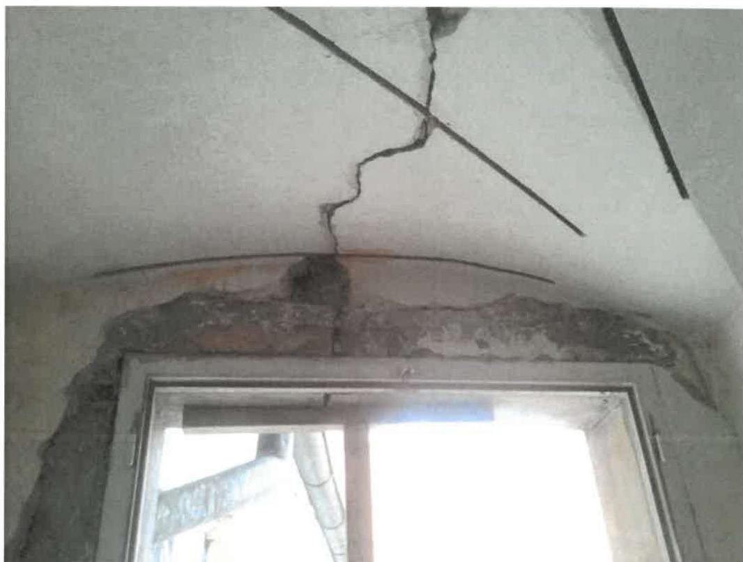
Foto 04 – příklad z realizace obdobné opravy sešití zdiva v místech poškozené klenby
