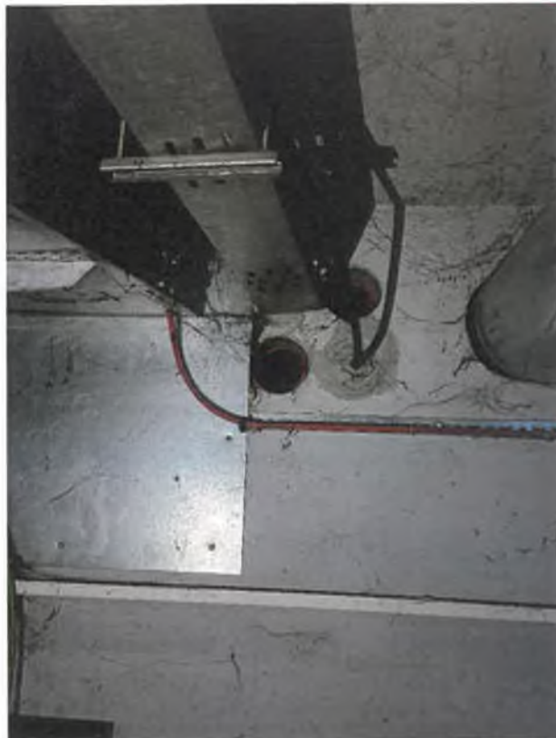
pohled z garáží v suterénu, volné trubky z kolektoru, přes které bude dům napojen
