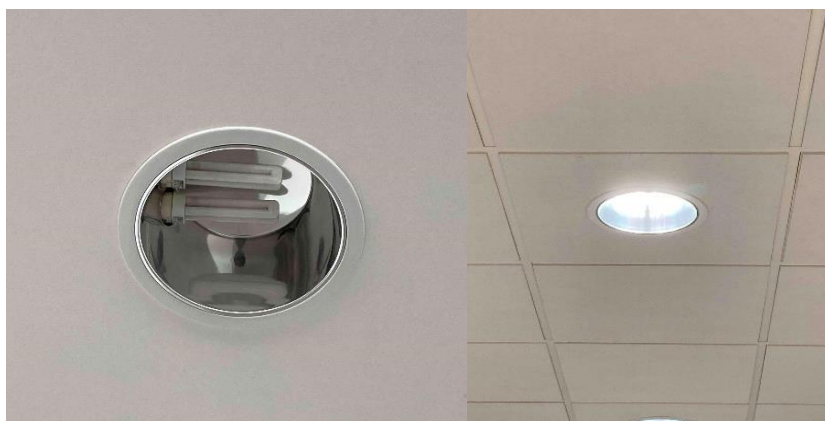
obr.1 stávající svítidla downlight
