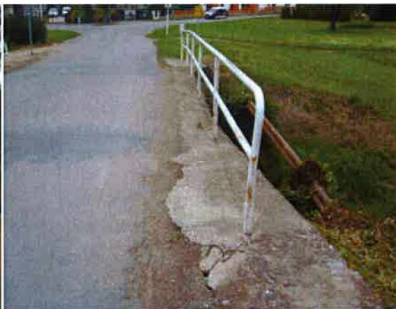
levá strana ( proti směru staničení )
