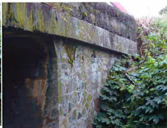
detail křídla na zač.mostu vlevo
