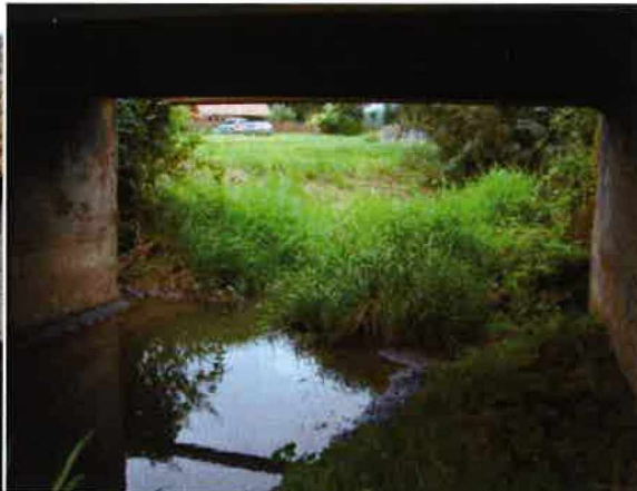
nános naplavenin a huminózní zeminy pod mostem
