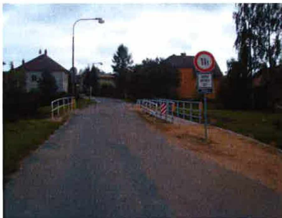
pohled ve směru staničení
