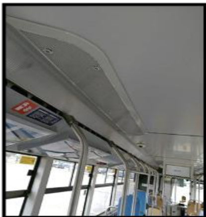
Obrázek č. 13 Umytí stropních krytů klimatizace
