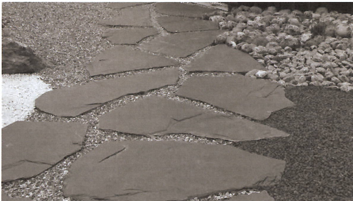
Ilustrační foto: zpěvněná plocha vodě propustná
