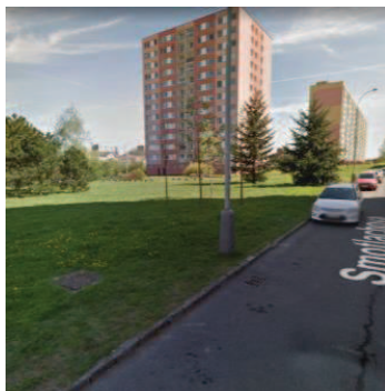
Foto- stávající stav
