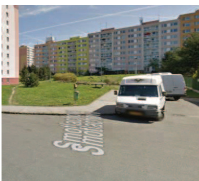
Foto- stávající stav
