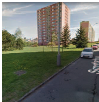
Foto- stávající stav
