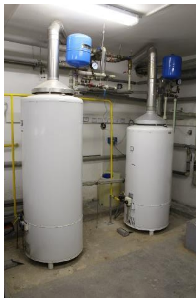
Obr. 64: Přímohřívané zásobníky TV
