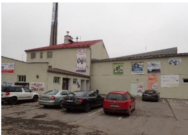
Obr. 190: Budova školy – od parkoviště
