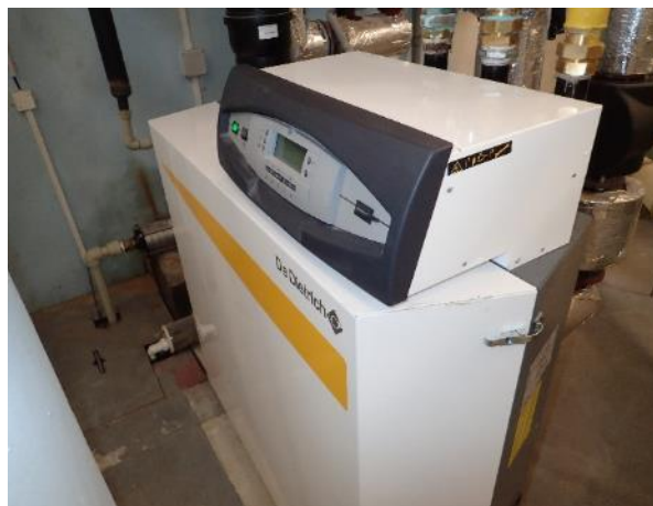
Obr. 107: Kotelna „A“, K1
