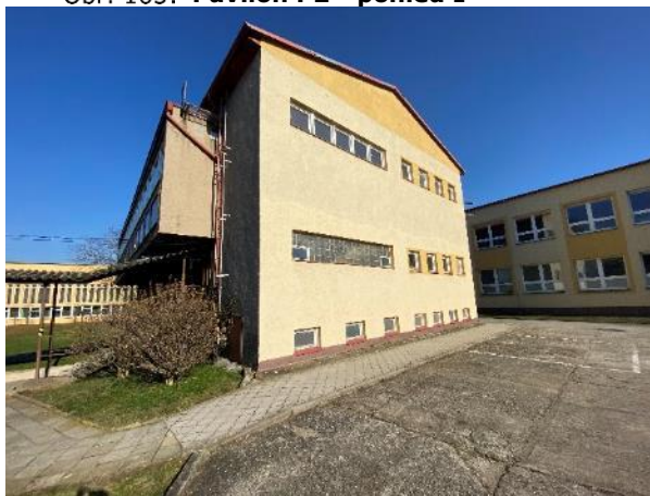
Obr. 167: Pavilon P2 - pohled III
