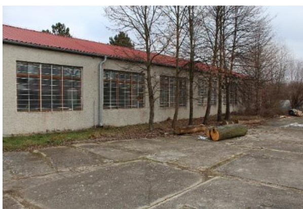
Obr. 148: Pohled III - Hala 2
