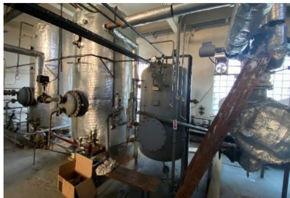
Obr. 206: Příprava TV ve VS
