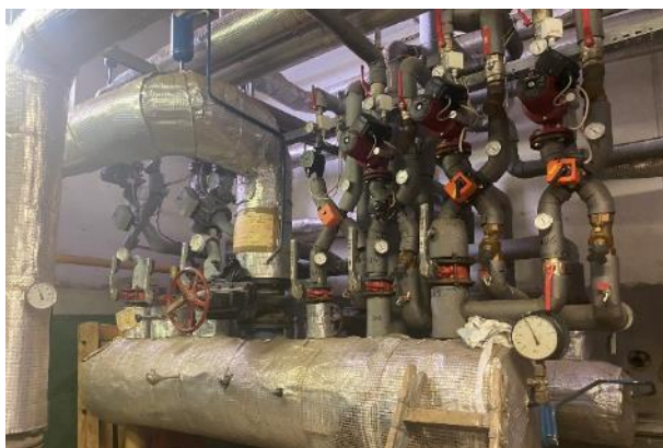
Obr. 134: Rozdělovač topných okruhů
