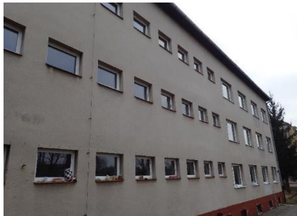
Obr. 184: Budova „A“, dvorní fasáda
