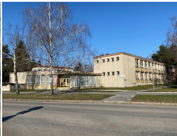
Obr. 201: Pavilon TV2 – pohled II
