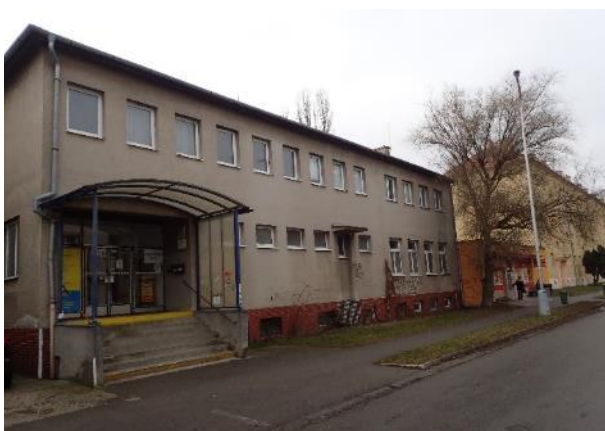
Obr. 185: Budova „B“, uliční fasáda
