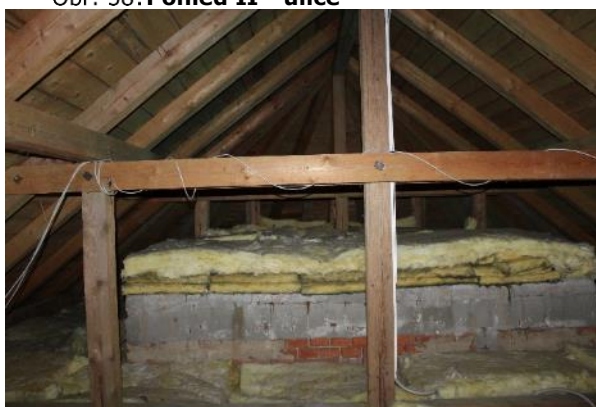
Obr. 60: Zateplení podlahy půdy
