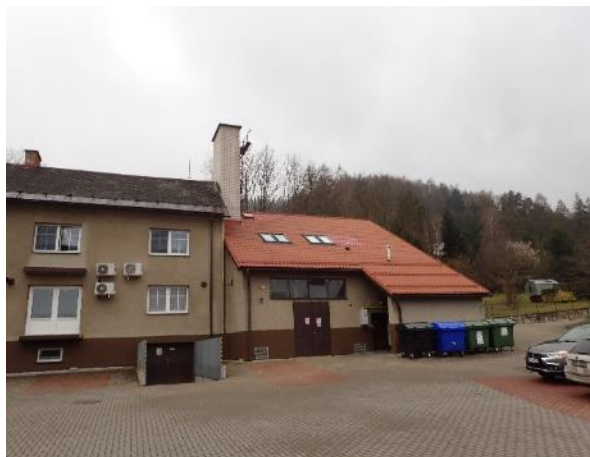
Obr. 41: Hospodářská budova s kotelnou
