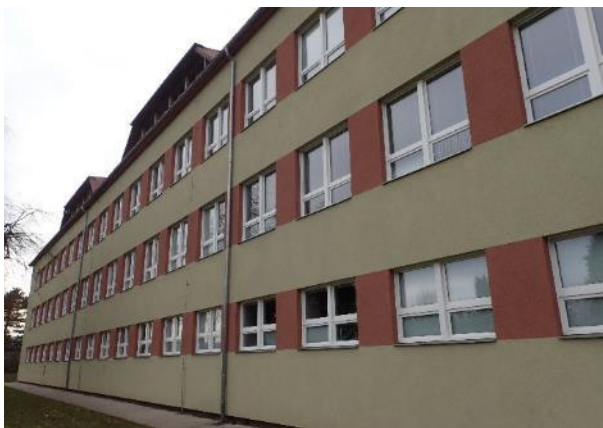
Obr. 192: Budova školy – JV pohled
