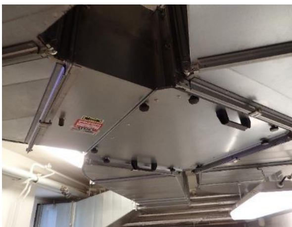
Obr. 46: Deskový rekuperační výměník
