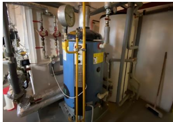
Obr. 38: Příprava TV pro půdní prostor hlavní budovy (plyn. ohřívač v popředí je odpojený)
