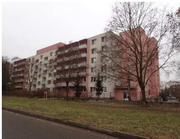
Obr. 70: Část „A“ z Krapkovy ulice
