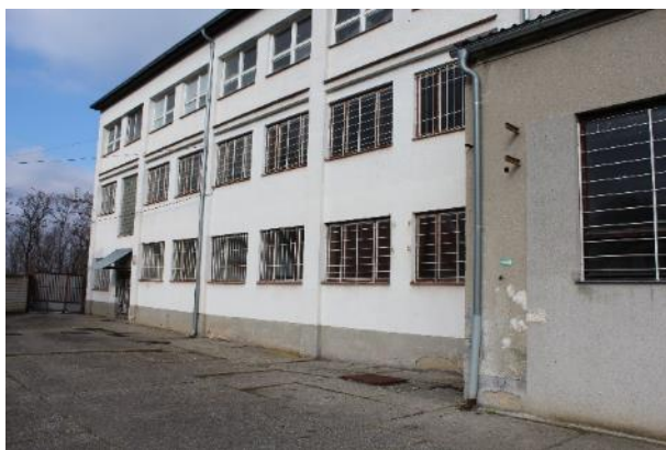
Obr. 146: Pohled I - Škola
