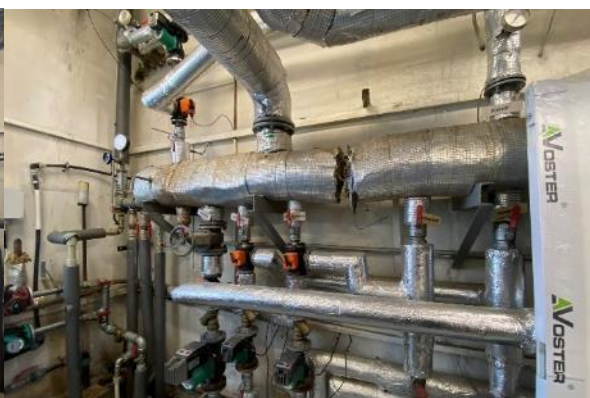
Obr. 205: R+S pro jednotlivé topné větve
