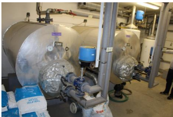
Obr. 63: Nepřímohřívané zásobníky TV
