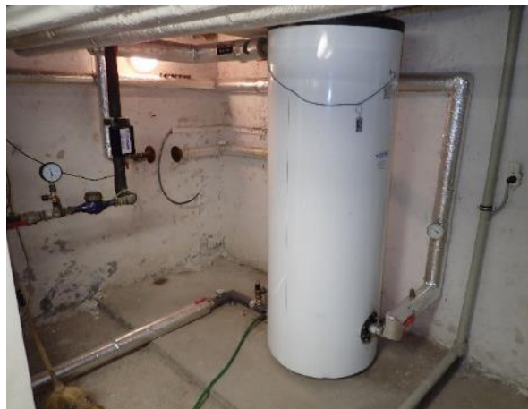
Obr. 25: Centrální příprava TV 9K
