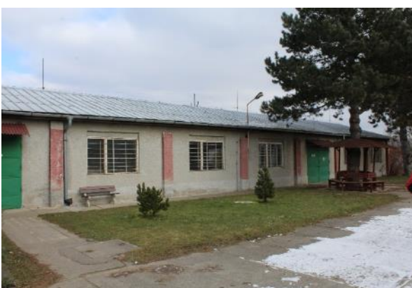
Obr. 149: Pohled IV - Hala 1
