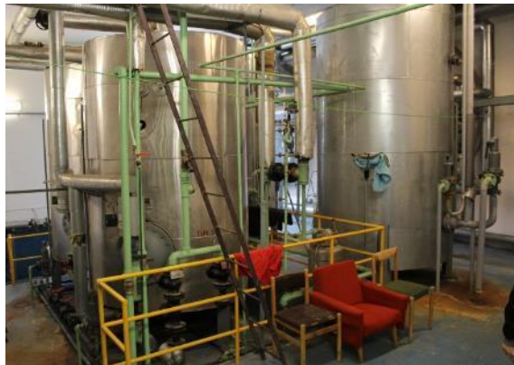
Obr. 141: Centrální příprava TV
