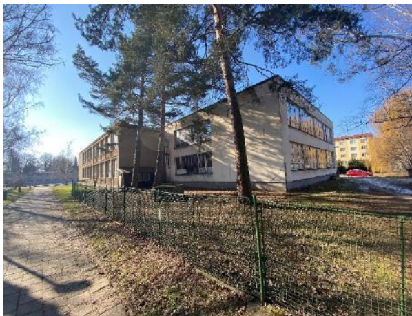
Obr. 200: Pavilon TV2 – pohled I
