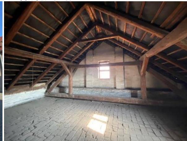
Obr. 93: Krov původní budova
