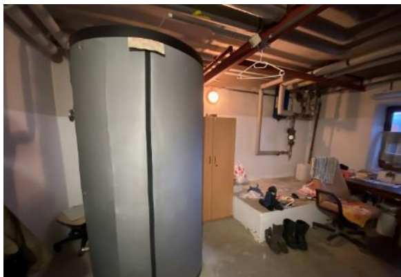
Obr. 37: Příprava TV pro první dvě patra hlavní budovy (hlavní kotelna)
