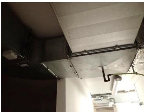
Obr. 181: Deskový rekuperační výměník
