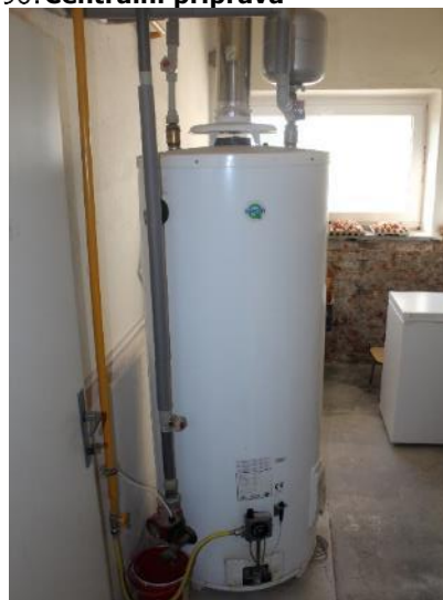
Obr. 97: Příprava TV pro kuchyň
