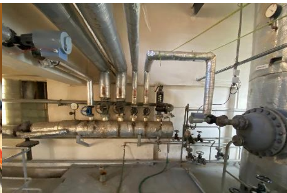
Obr. 203: Rozdělovač pro TV a výměníky
