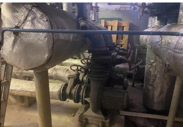
Obr. 135: Hnací oběhová čerpadla
