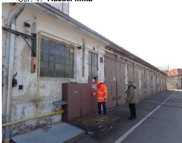
Obr. 6: Akumulátorovna +ČOV – vstup ke zdroji tepla
