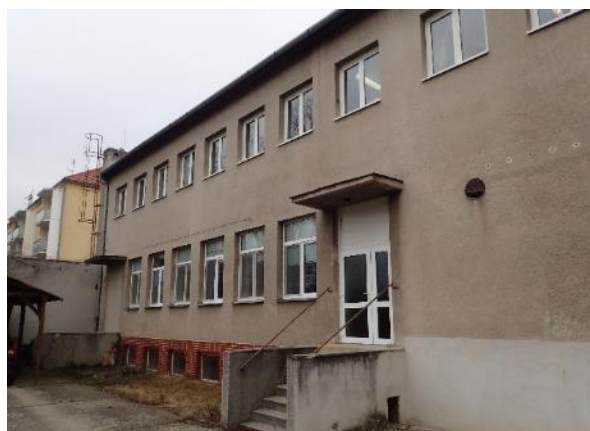
Obr. 186: Budova „B“, dvorní fasáda
