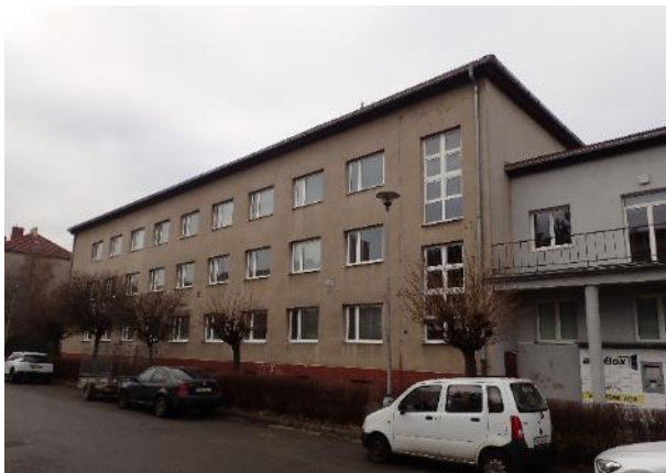
Obr. 183: Budova „A“, uliční fasáda
