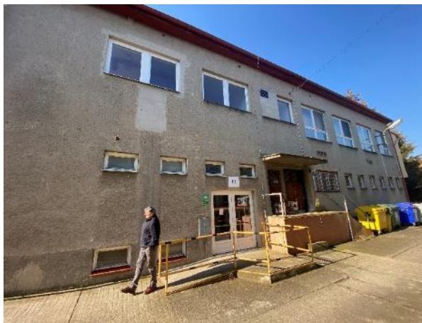
Obr. 166: Pavilon P2 - pohled II
