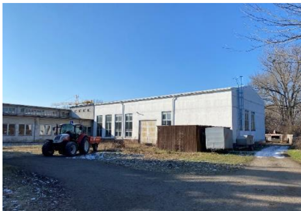
Obr. 212: Nová hala – pohled I
