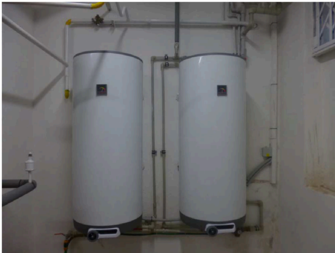
Obrázek: dvojice elektrických závěsných boilerů pro ohřev TUV fy Dražice o objemu á160 L o el. příkonu á=2,2kW. K ohřevu TUV
