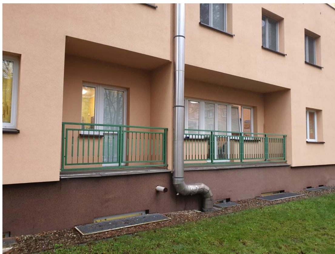
Nátěr zábradlí a oplechování na budově A (délka zábradlí cca 8,3m, výška zábradlí 0,97m)
