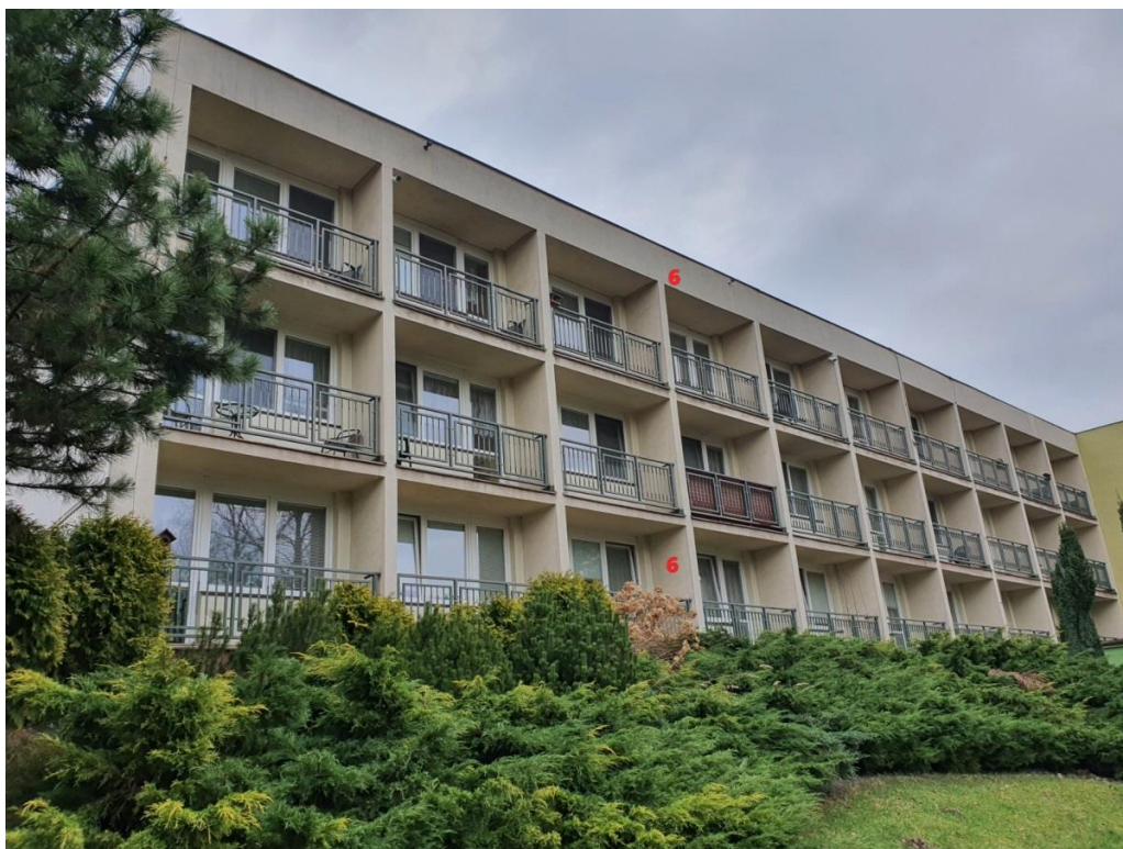
budova B – jihozápadní strana s lodžemi (označeno č.6), nátěr 30 ks zábradlí a oplechování lodžii (délka zábradlí cca 3,5m, výška zábradlí 0,97m)
