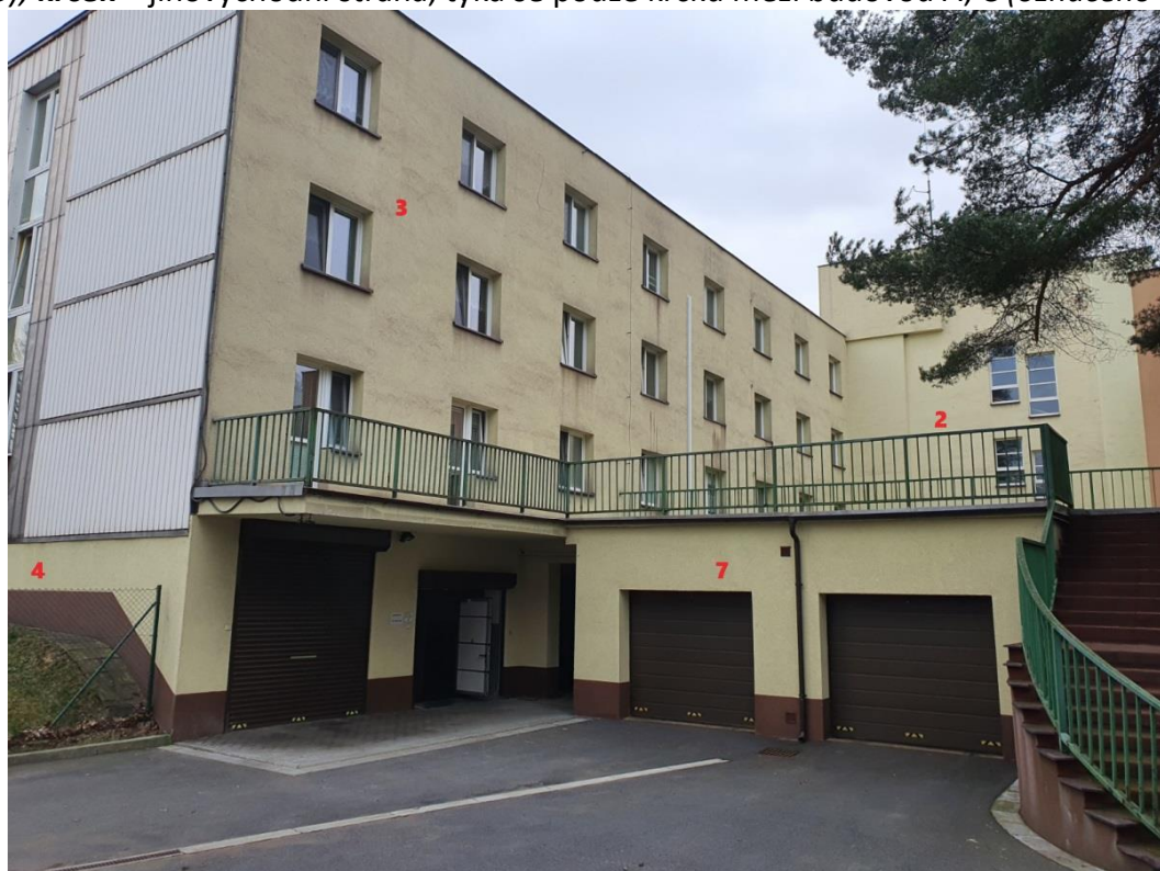
budova C – severovýchodní strana (označeno č.3), krček – jihovýchodní strana, týká se pouze krčku mezi budovou A, C (označeno č.2), jihovýchodní soklová část budovy (označeno č.4), stěny přilehlých garáží u budovy C (označeno č.7), nátěr zábradlí a oplechování terasy nad garážemi (délka zábradlí cca 44,0m, výška zábradlí 0,97m)
