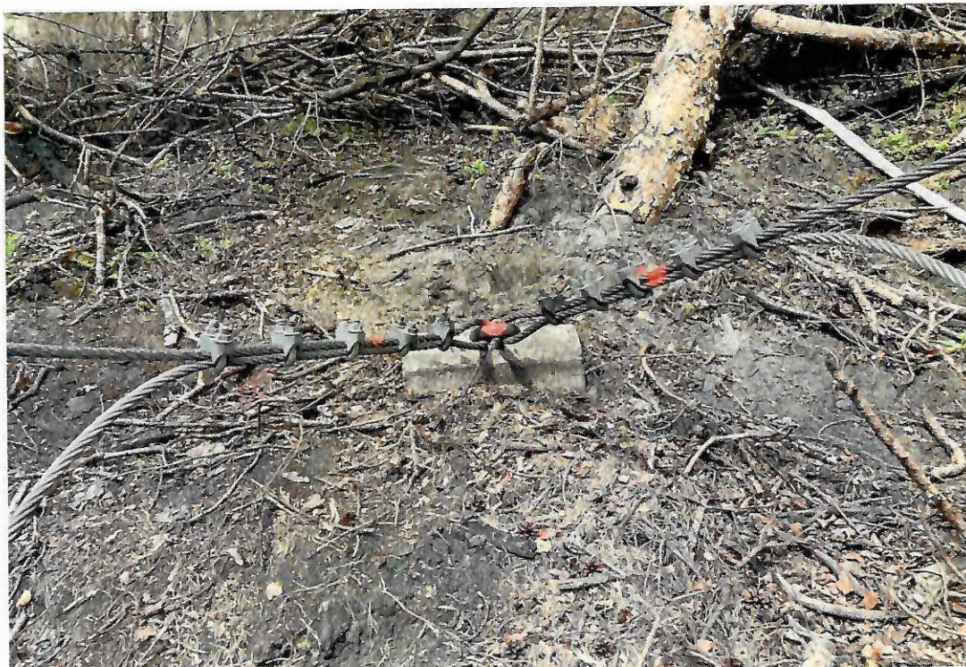
Lanová kotva určená k výměně
