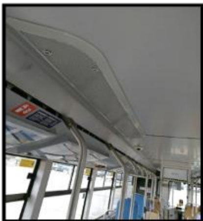
Obrázek č. 13 Umytí stropních krytů klimatizace
