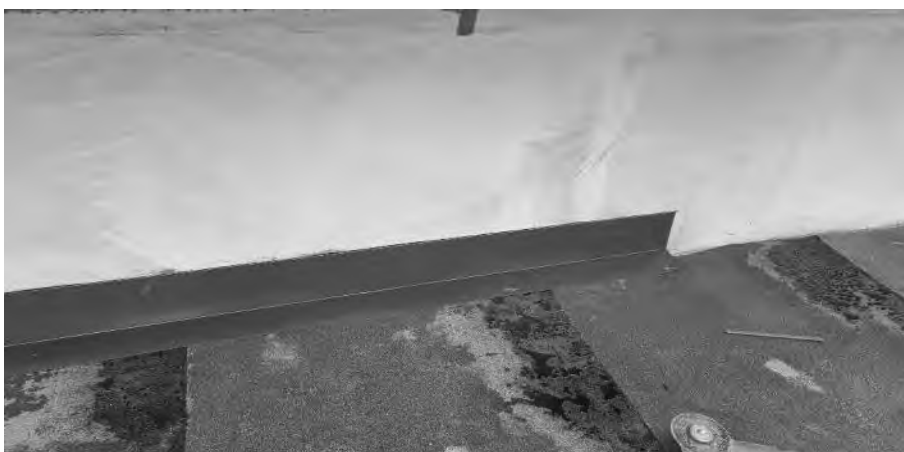
Dodatečné lemování - přechod střecha/stěna
