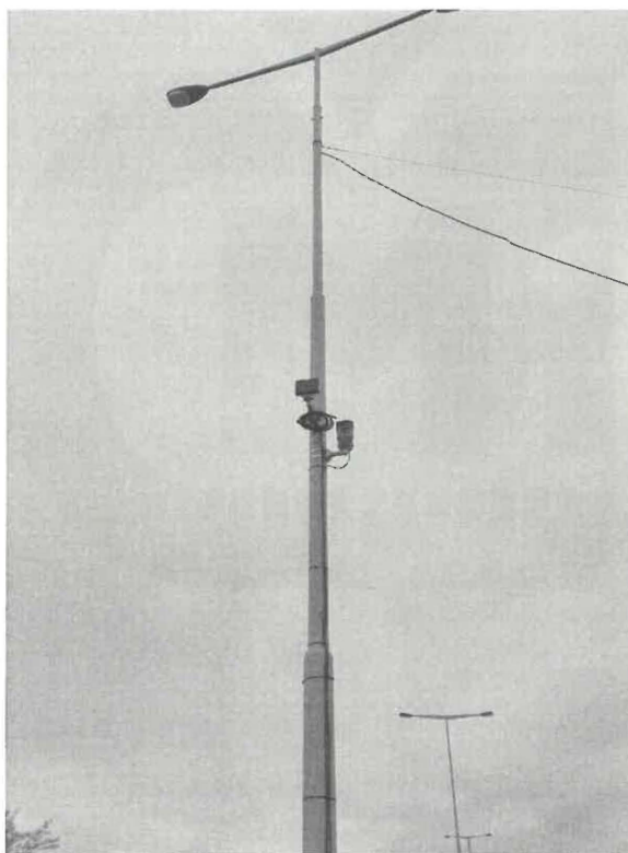
Obr. 6 Instalace snímáče a kamery na sloupu veřejného osvětlení
