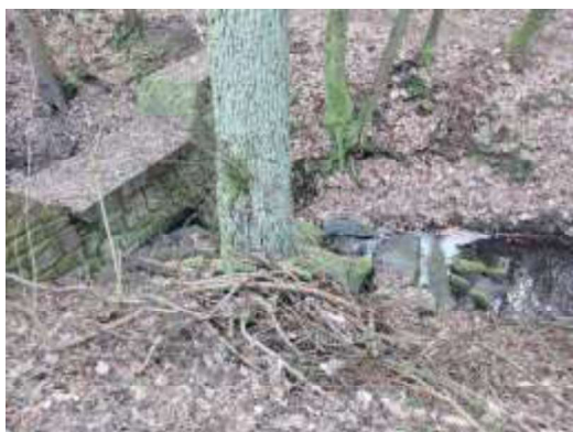
- kamenná přehrážka v ř.km 3,805
