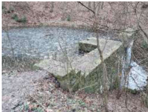
- kamenná přehrážka v ř. km 3,835
