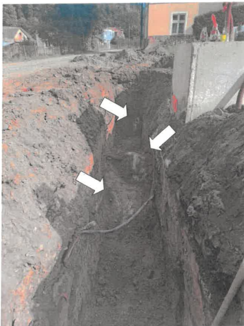
Skalní výchozy / bloky v rýze propustku km 7,792 – 7,863; SO 602.3, dílčí úsek cca km 7,819 – 7,827
