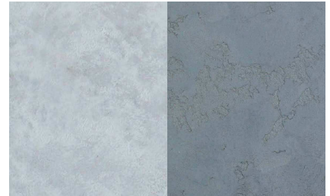
Betonová stěrka zalakovaná
