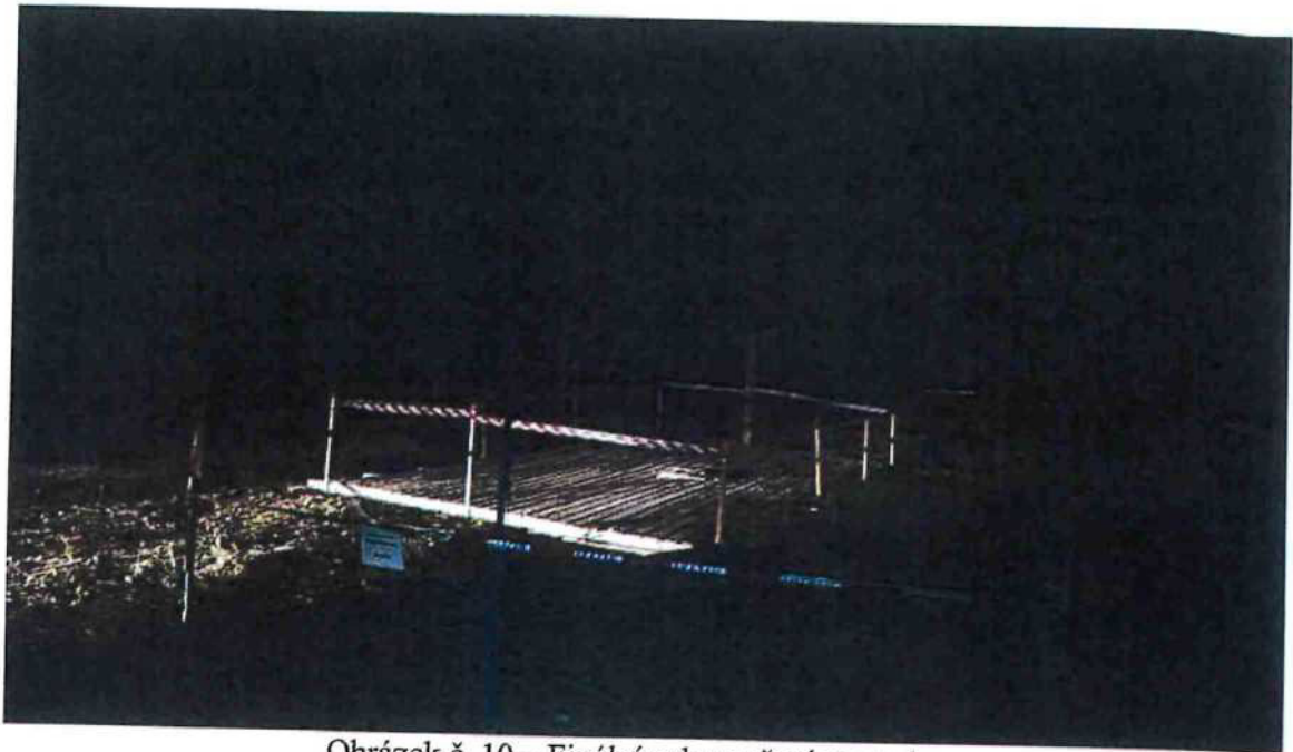
Obrázek č. 10 – Finální zabezpečení propadu
