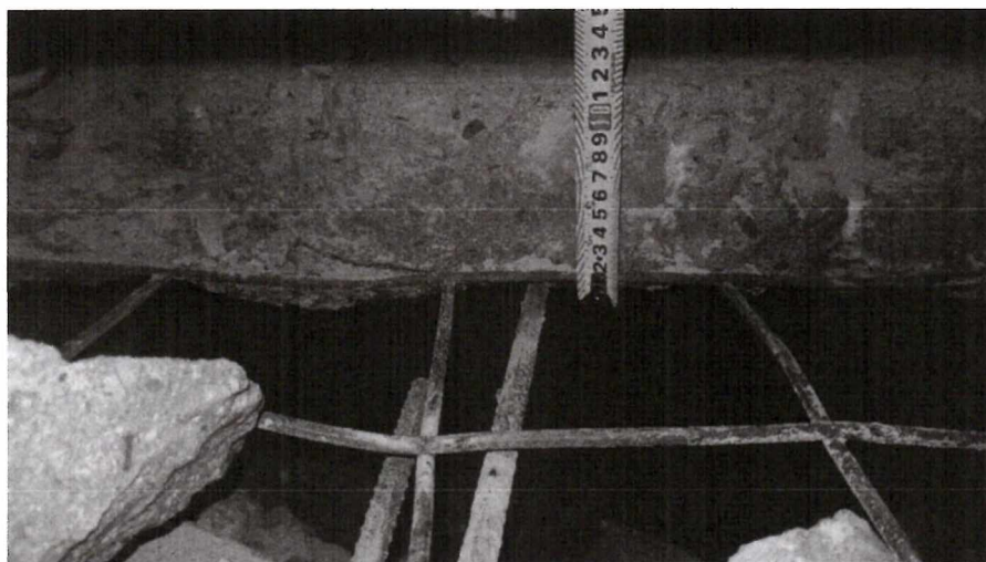
Obr. 4 – Mazanina s vloženou KARI sítí tl. 120 mm
