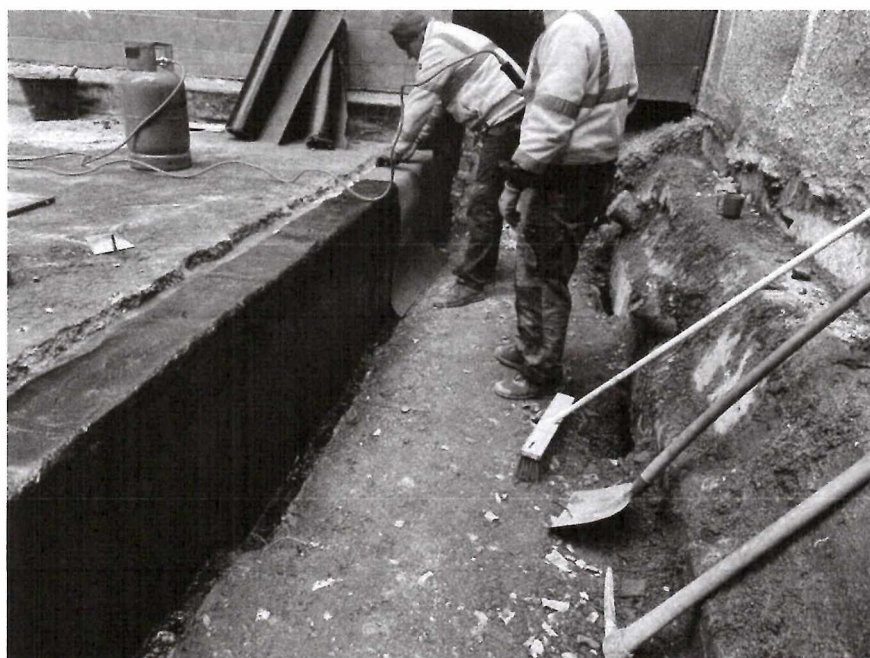
Obr. 11 – Provedení izolace proti zemi vlhkosti
