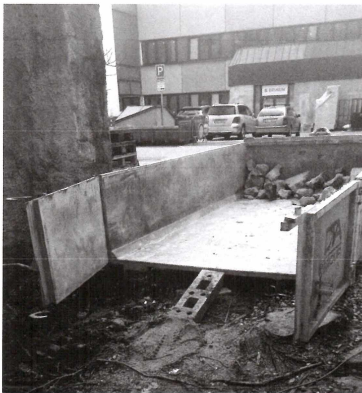
Obr. 6 – Ruční přesun suti v rámci staveniště
