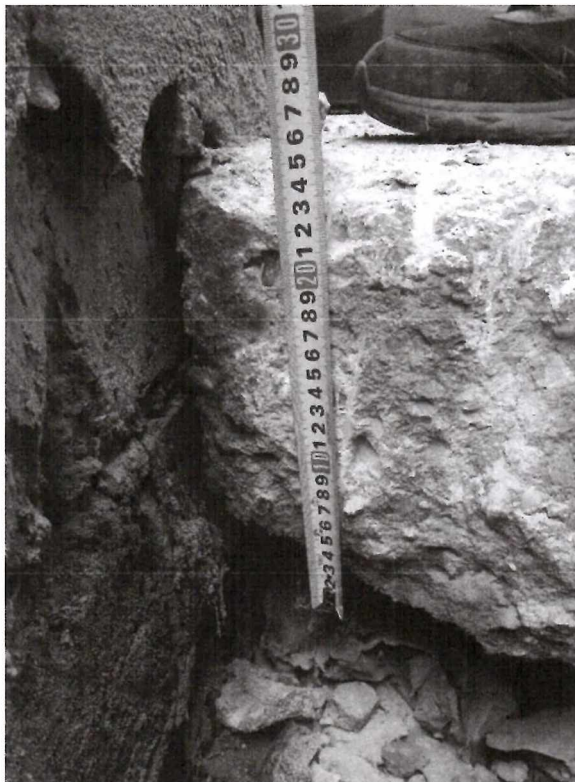
Obr. 3 – Okapový chodník z prostého betonu tl. 250 - 300 mm
