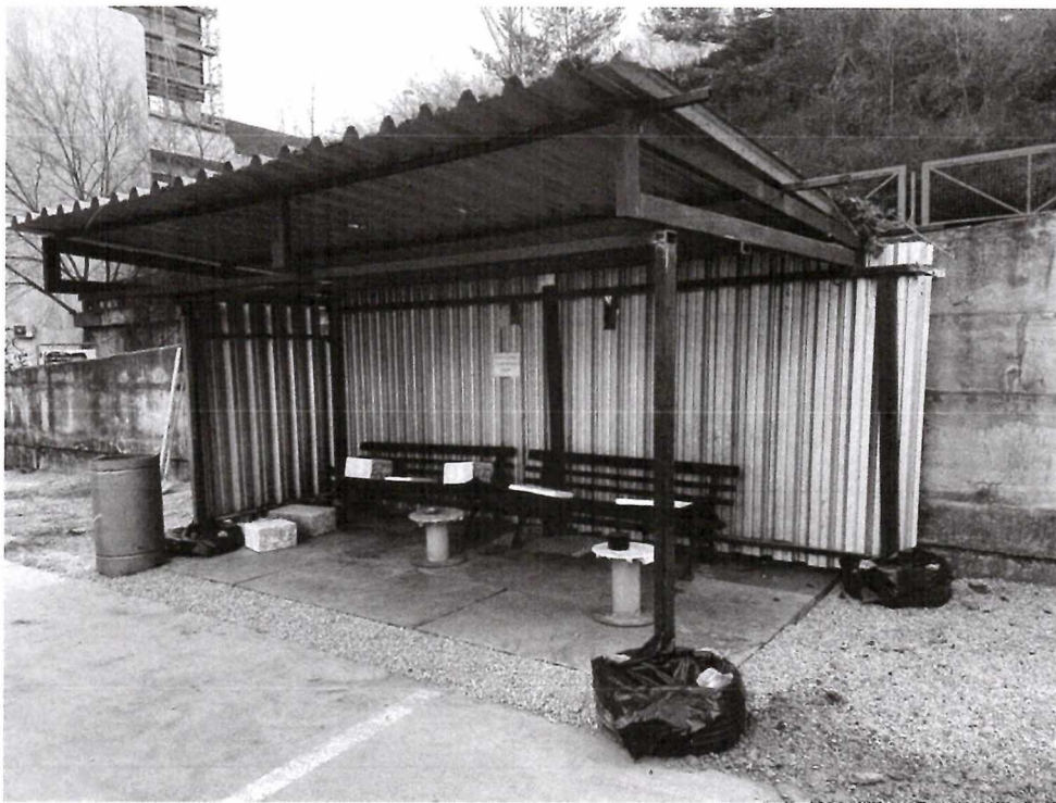
Obr. 5 – Přesunutá provizorní kužárna
