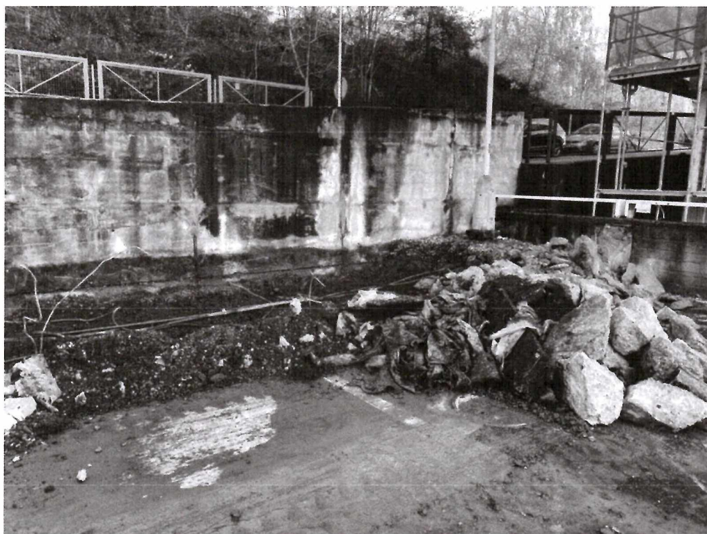
Obr. 9 – Vnitrostaveništní přesun suti
