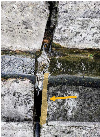
Foto č. 3 – Vzorek astarové závlivky vyjmutý ze spáry. Odtřzení závlivky od stěny dilatační spáry (viz šipka).
