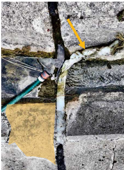
Foto č. 2 – Odtřzení závlivky od stěn dilatační spáry (viz šipky).
