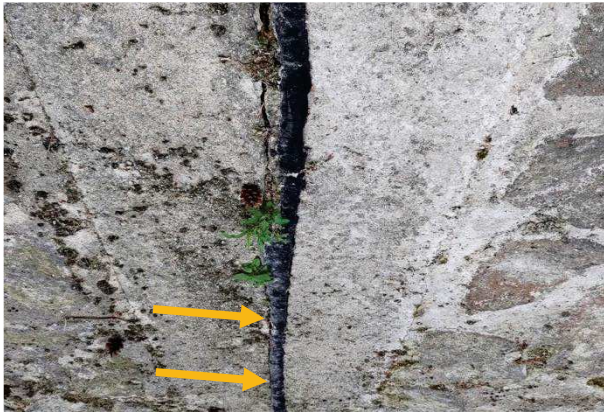
Foto č. 2 – Odtřzení závlivky od stěn dilatační spáry (viz šipky).
