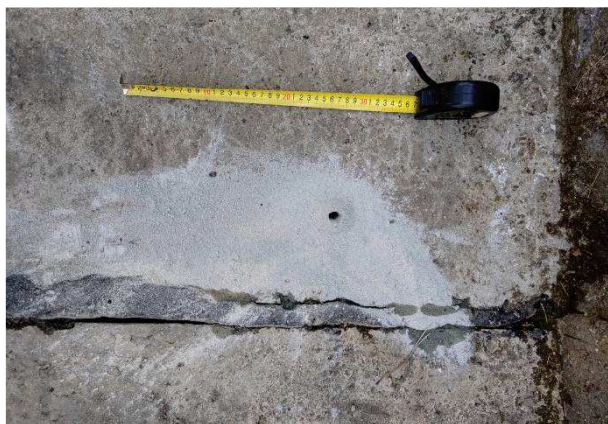
Foto č. 6 – Dobetonávka spáry mezi tvarovkami žlabu (barevná plocha), odřazení od tvarovky žlabu (viz šipka).
