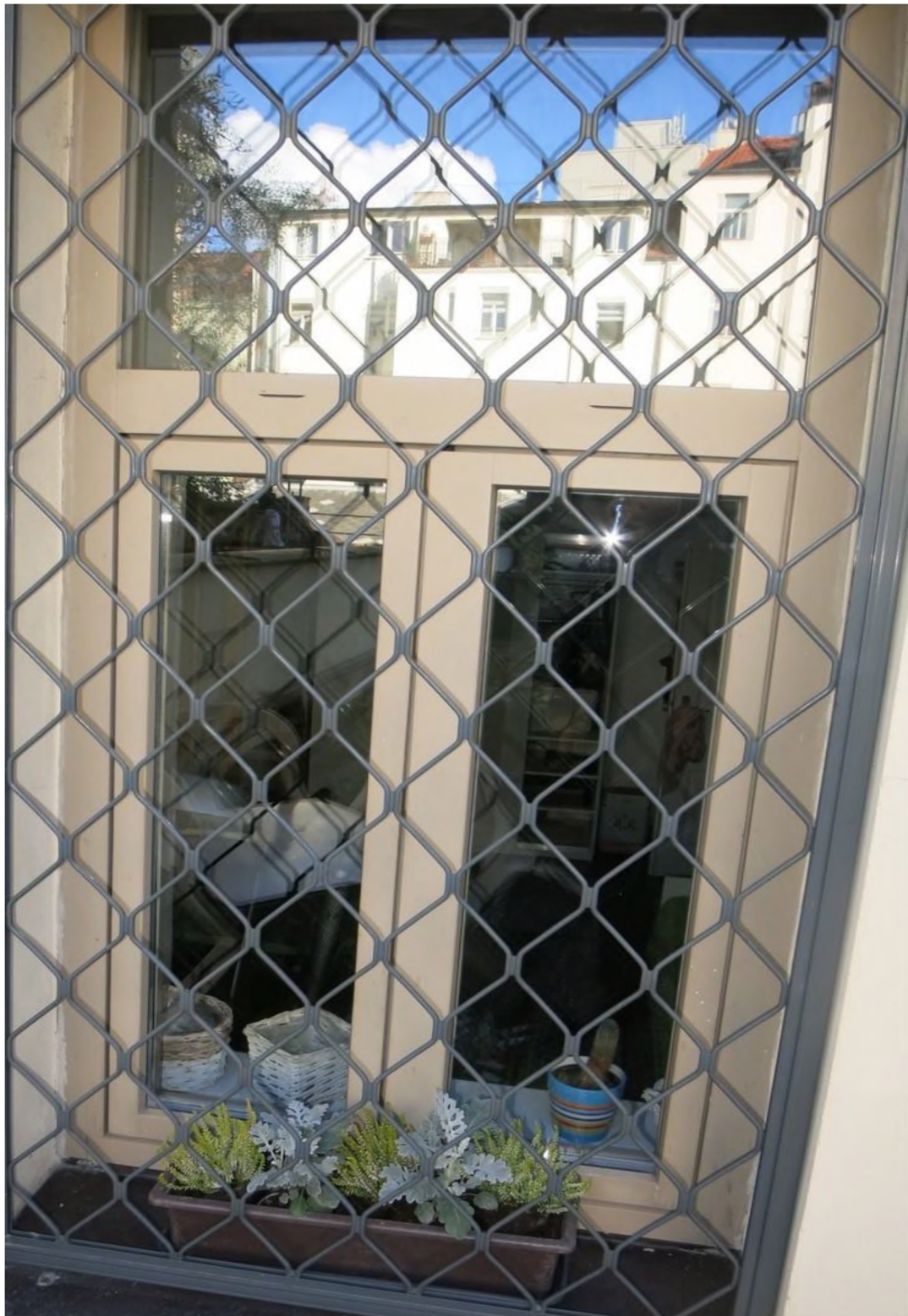
Okno 7 v 1.NP – dvorní fasáda
