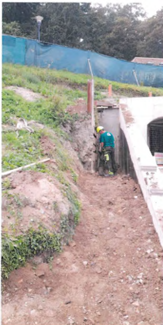
Foto natřené levé zdi portálu
