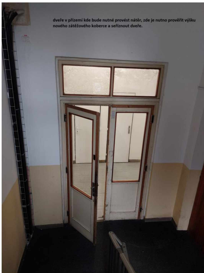
drhnoucí dveře o koberec, koberec na výměnu
