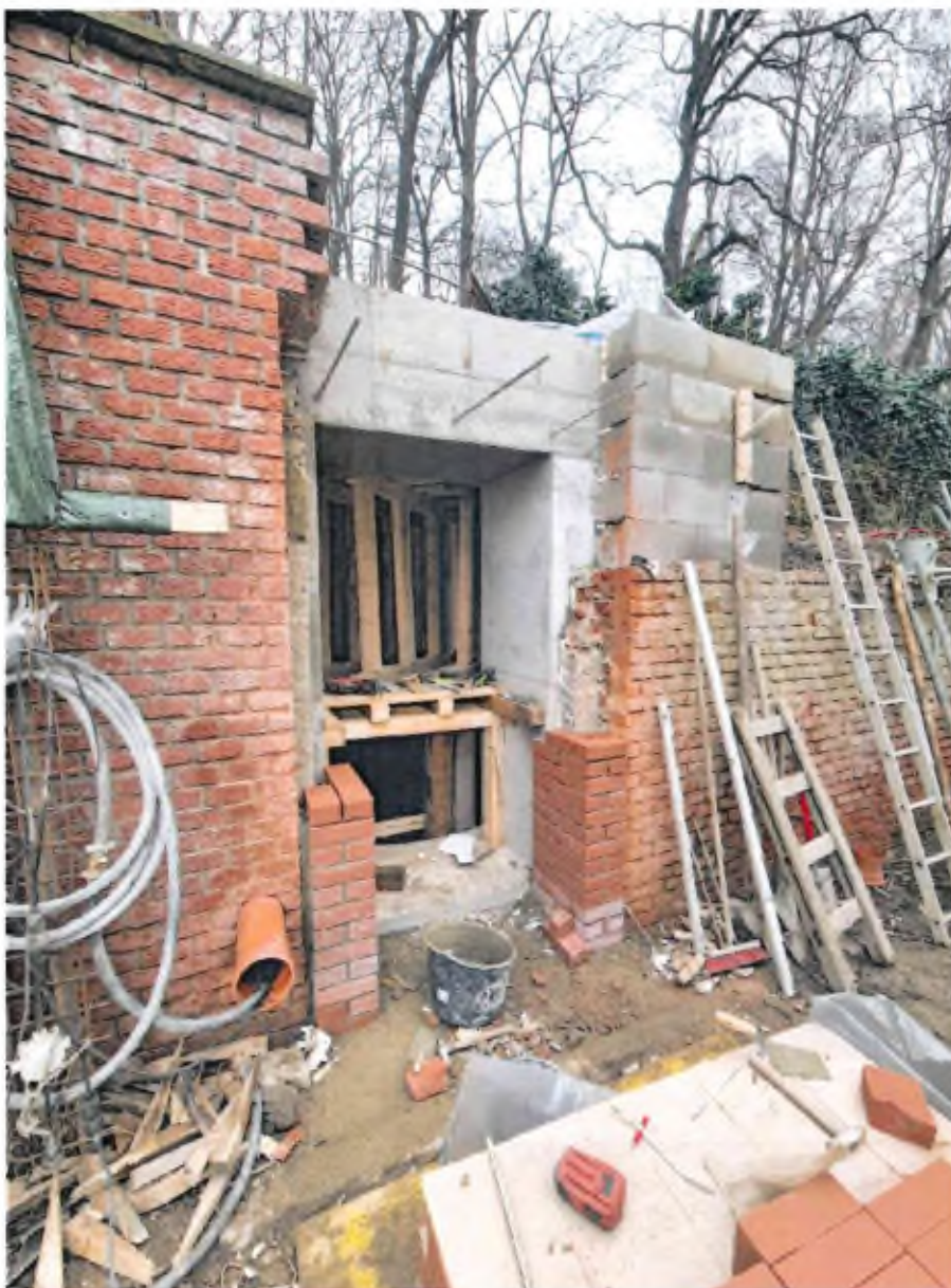
Foto: Provádění dozdivky čelního zdiva
