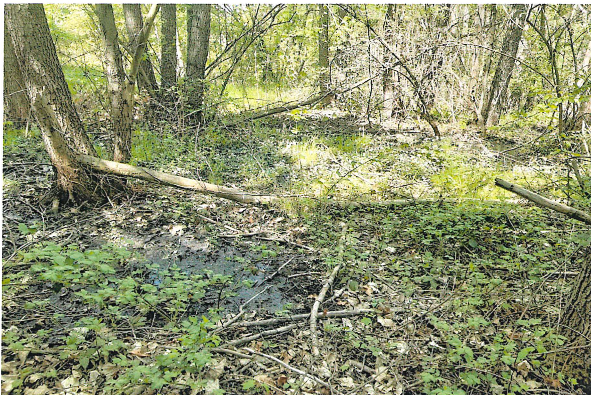
SO 03 - Patní drén, zamokření v podhrází
