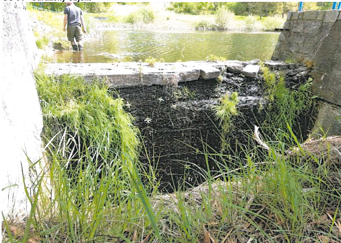
SO 01 - Sdružený objekt – detail přelivu 1
