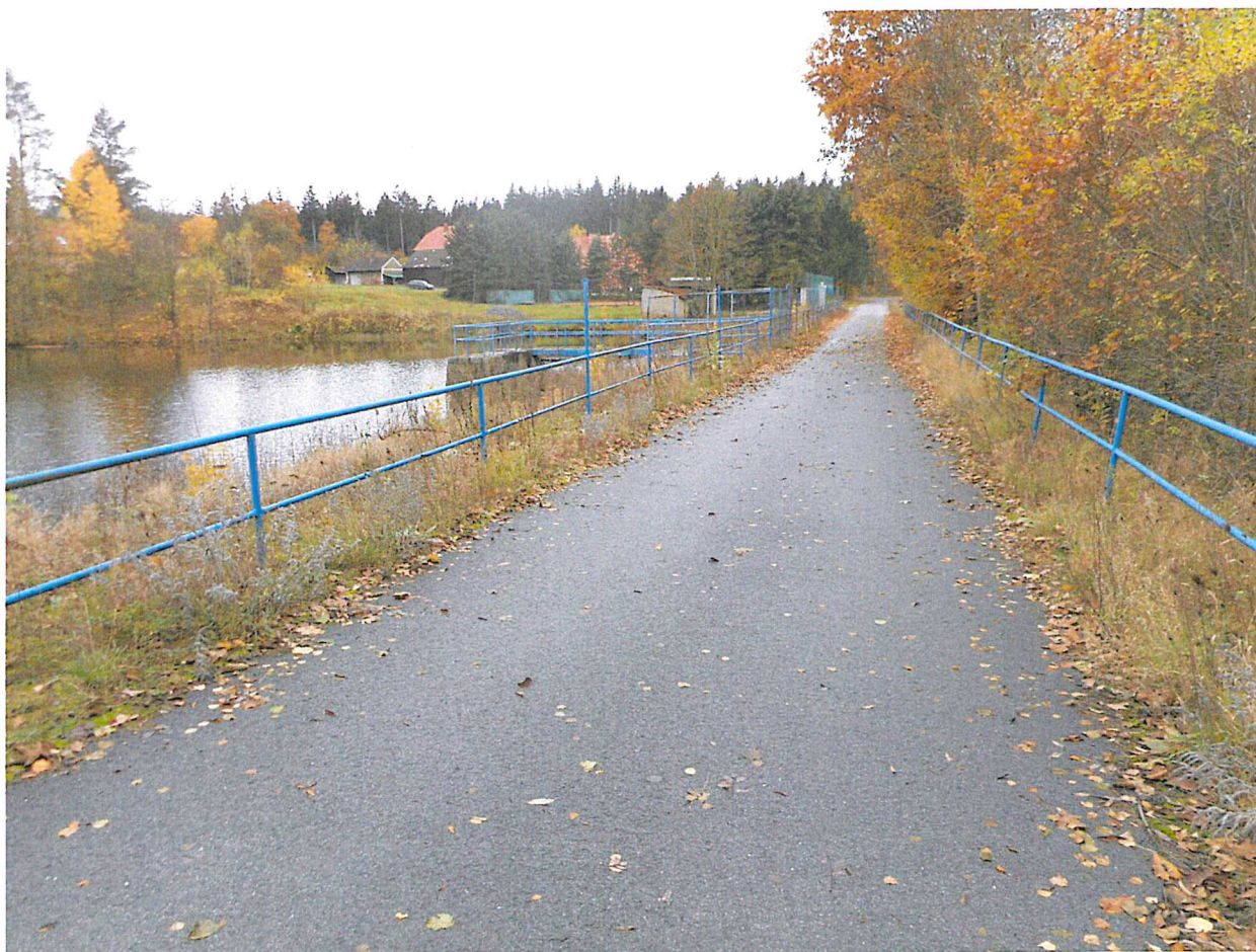
SO 04 – stávající zábradlí na hrázi
