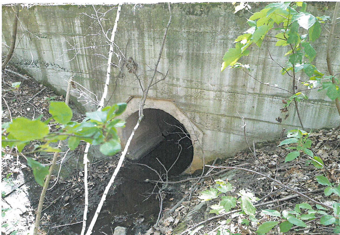
SO 02 - Sdružený objekt - odpadní potrubí DN 1200, vzdušní líc hráze
