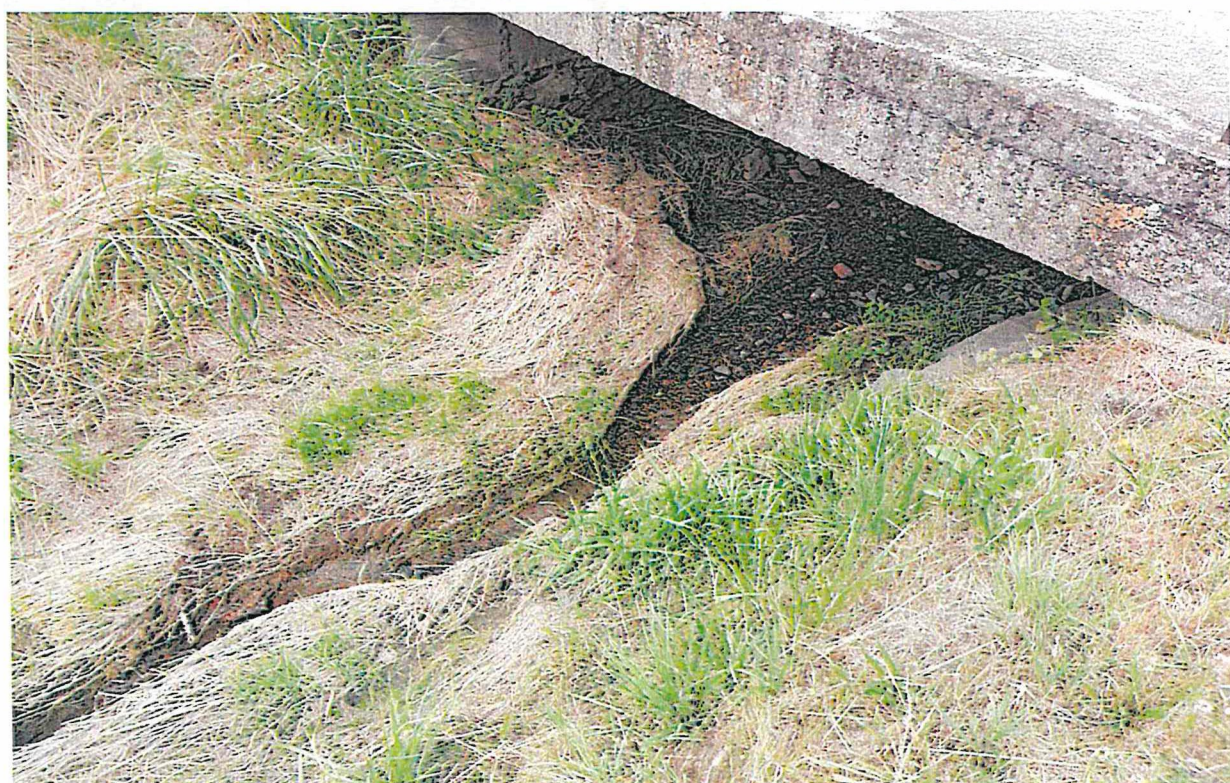
4. Pravý břeh VT, ř.km 1,33
