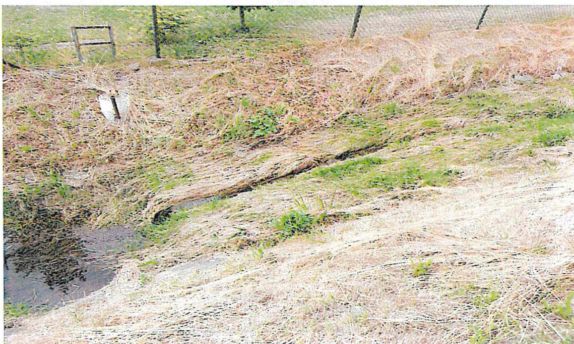
2. Pravý břeh VT, ř.km 1
