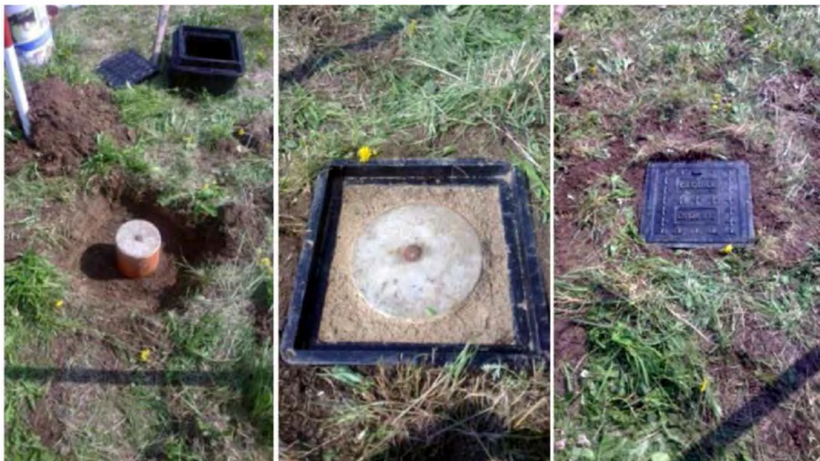
Obrázek 41 Příklad řešení plastové šachty hranaté
