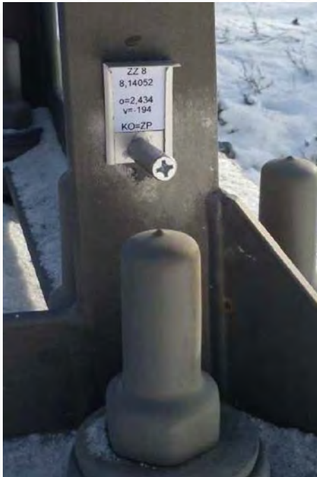
Obrázek 9 Konzolová značka na podpěře trakčního vedení
