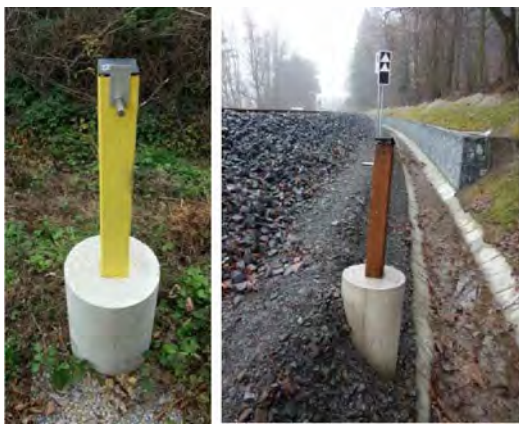
Obrázek 16 Zajišťovací značka umístěná do výškové úrovně kolejnicových pásů s odkrytým betonovým základem při bližším pohledu
