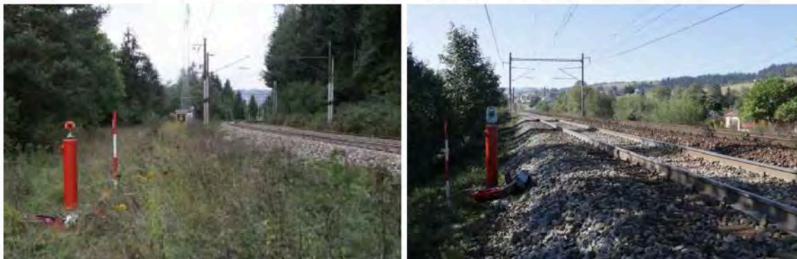
Obrázek 38 Pilíře s nucenou centrací na aktuálně probíhající stavbě na Slovensku
