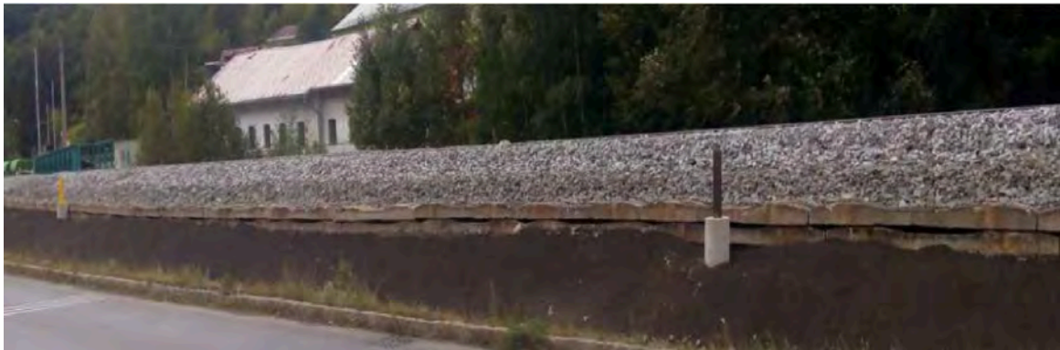
Obrázek 15 Zajišťovací značka umístěná do výškové úrovně kolejnicových pásů s odkrytým betonovým základem
