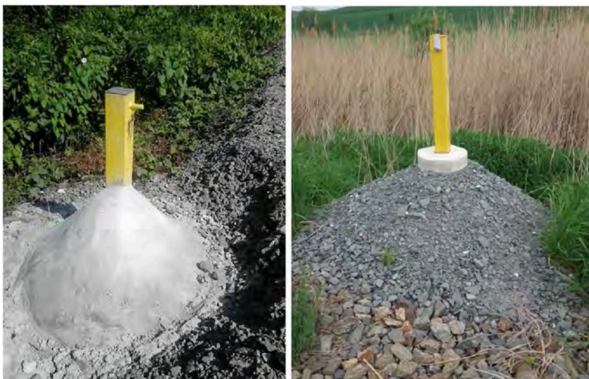
Obrázek 17 Řešení zhotovitele pro zvýšení stability zajišťovací značky
